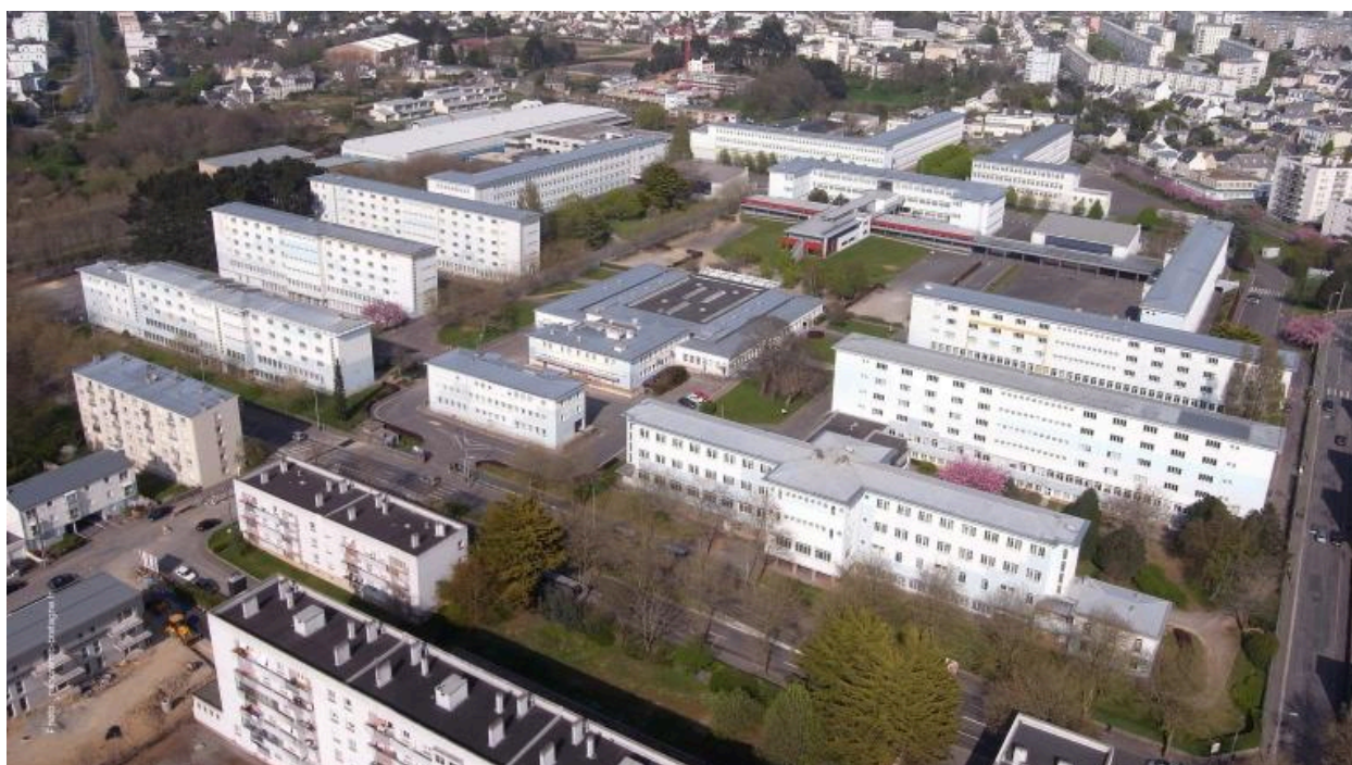
Vue aérienne oblique d'ensemble prise du sud-ouest en 2010.
