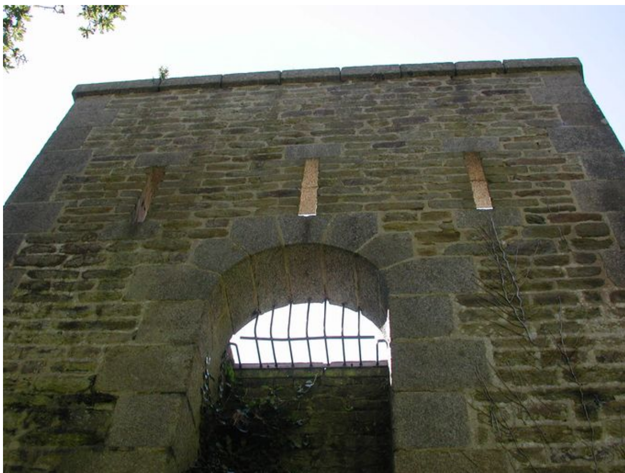
Vue du fort du Dellec : bastionnet percé de créneaux de fusillade et doté de mâchicoulis ou créneaux de pied
