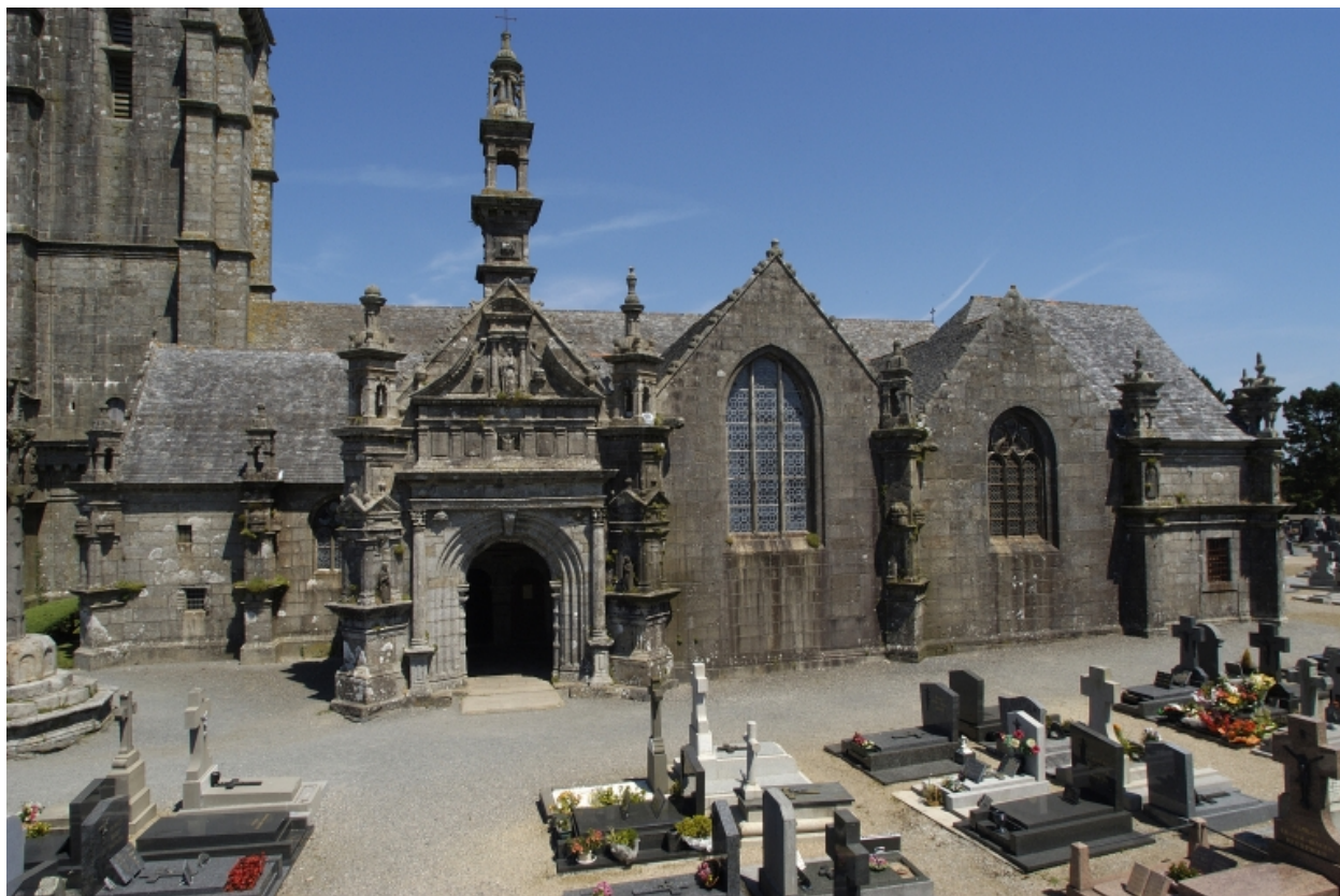
Eglise : élévation sud, vue générale
