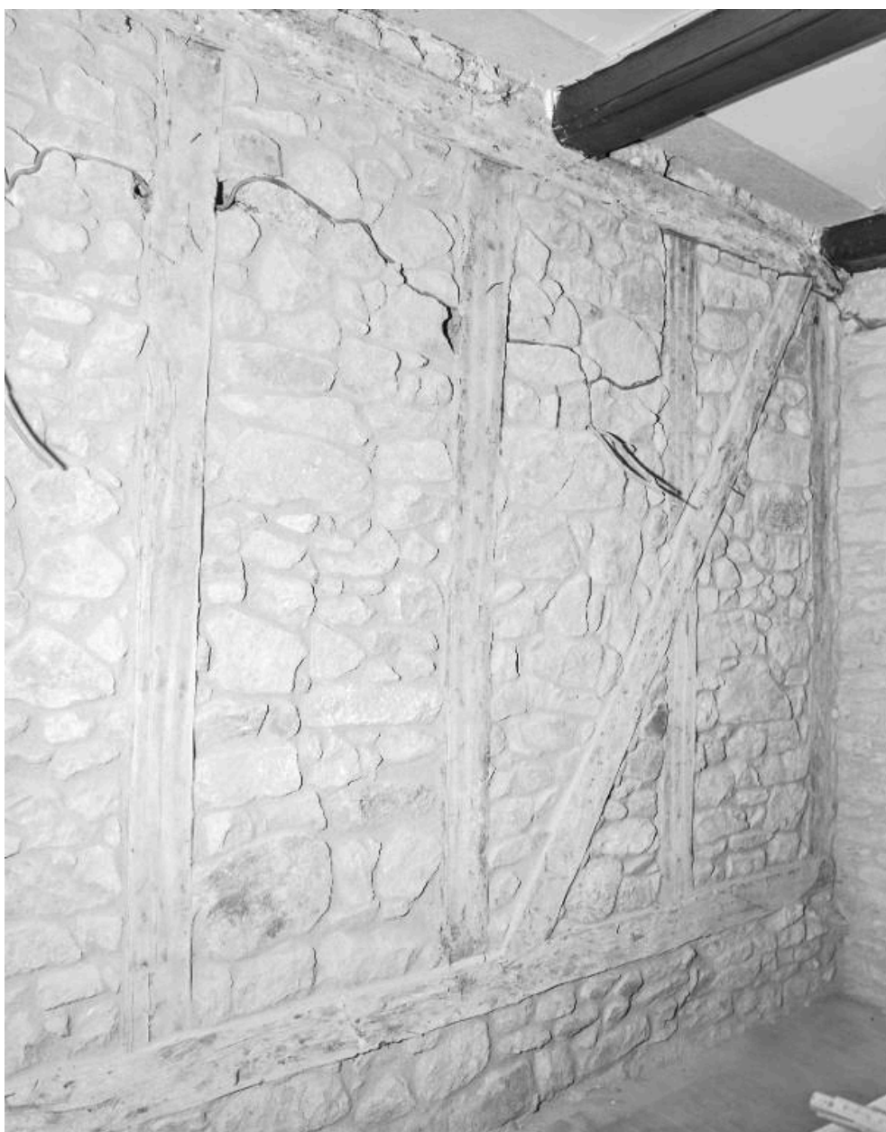
Mur de refend du vestibule
