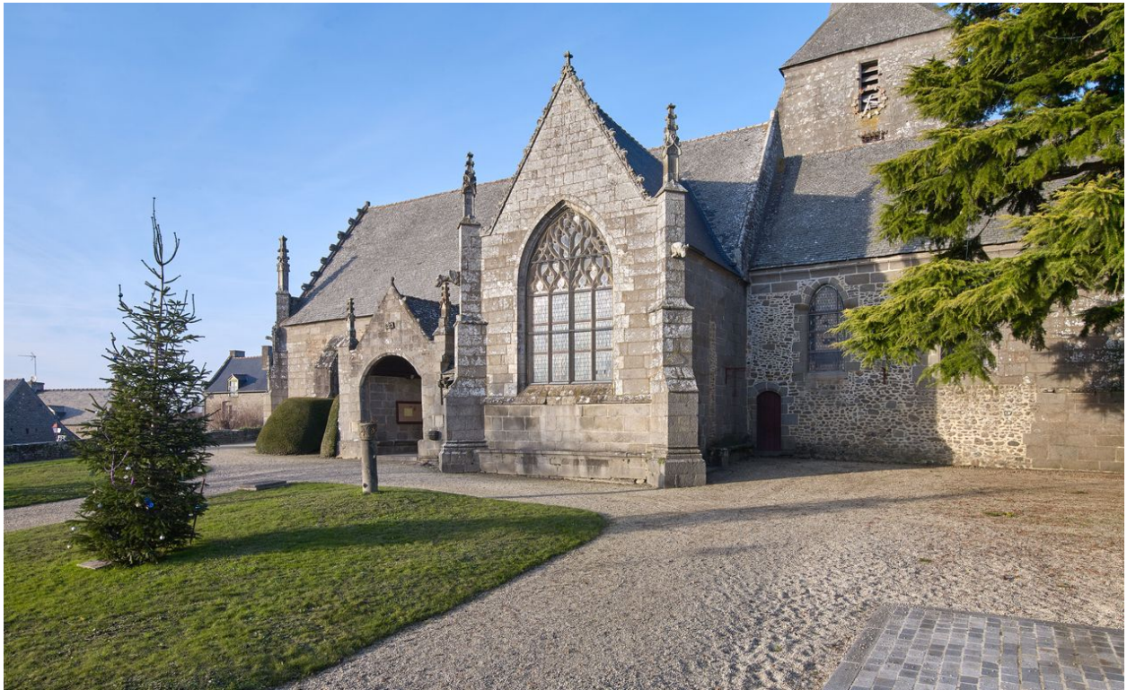
Façade sud depuis l'est
