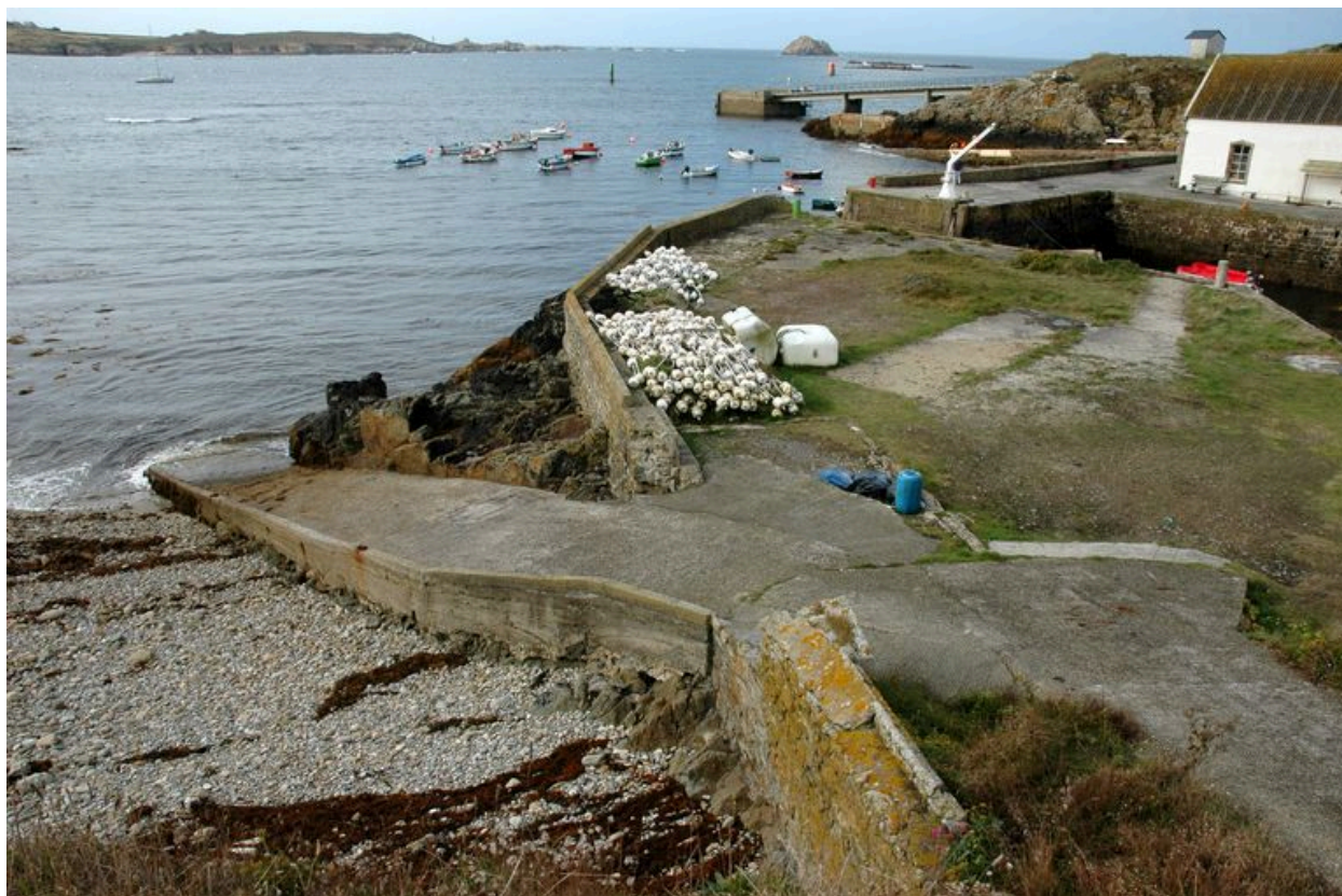
Vue du port-abri de Lampaul
