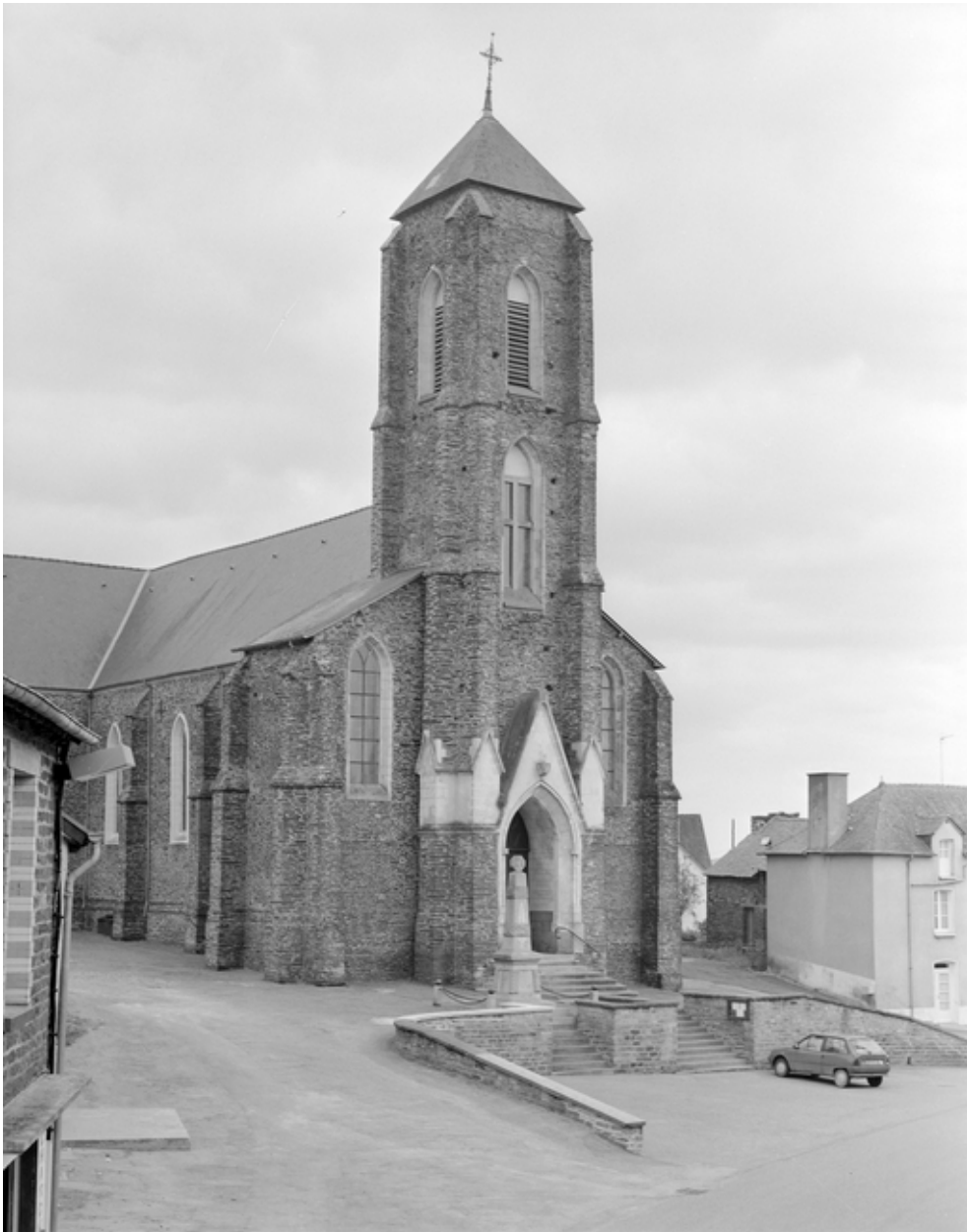
Le clocher : vue générale nord-ouest
