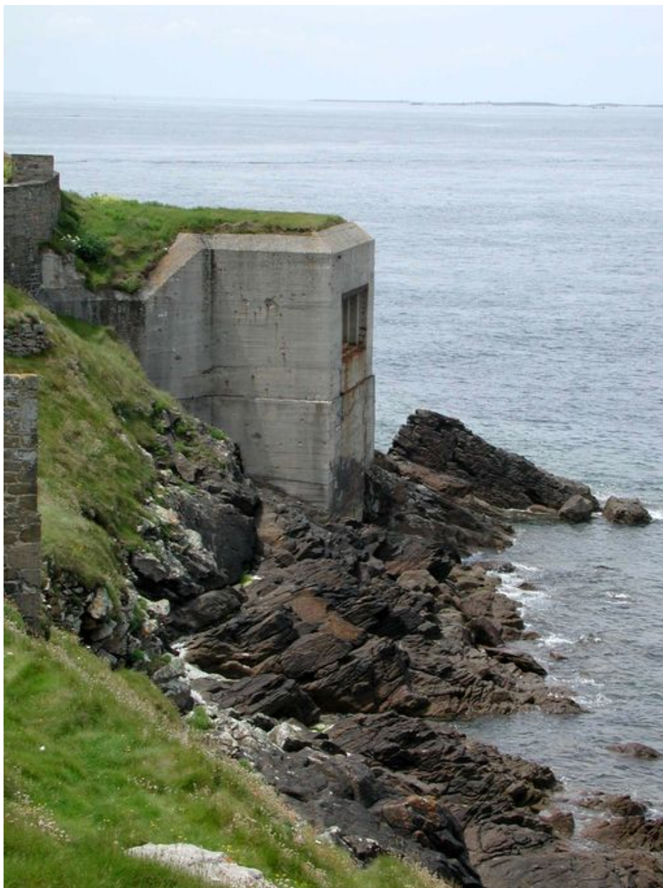
Vue générale de la casemate Nord
