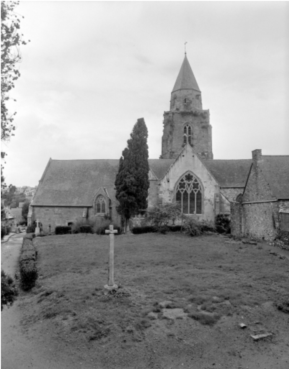
Elévation sud : vue générale
