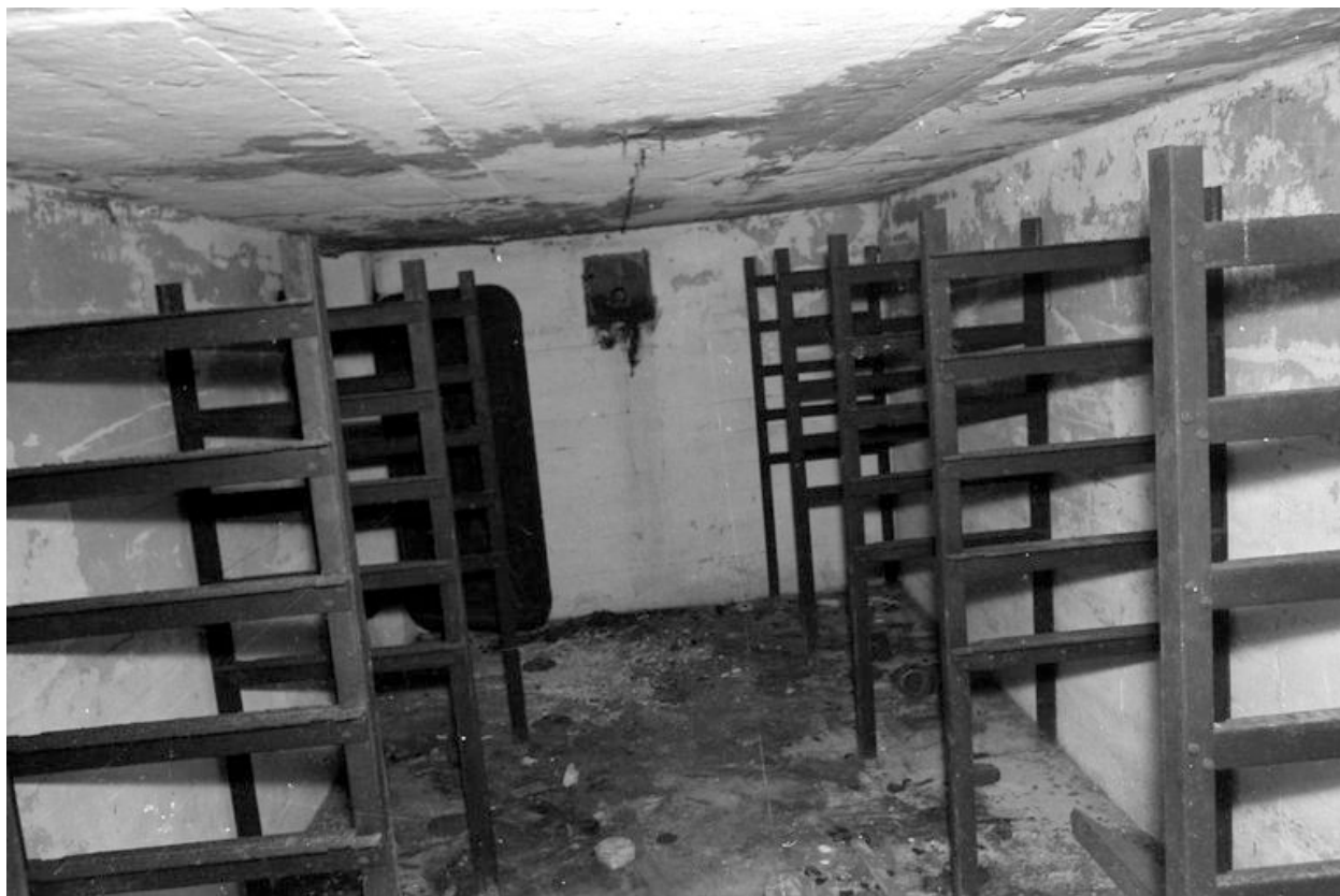
Vue intérieure de l'une des quatre cuves à canon : magasin des gargousses, étagères de stockage (état en 1969)
