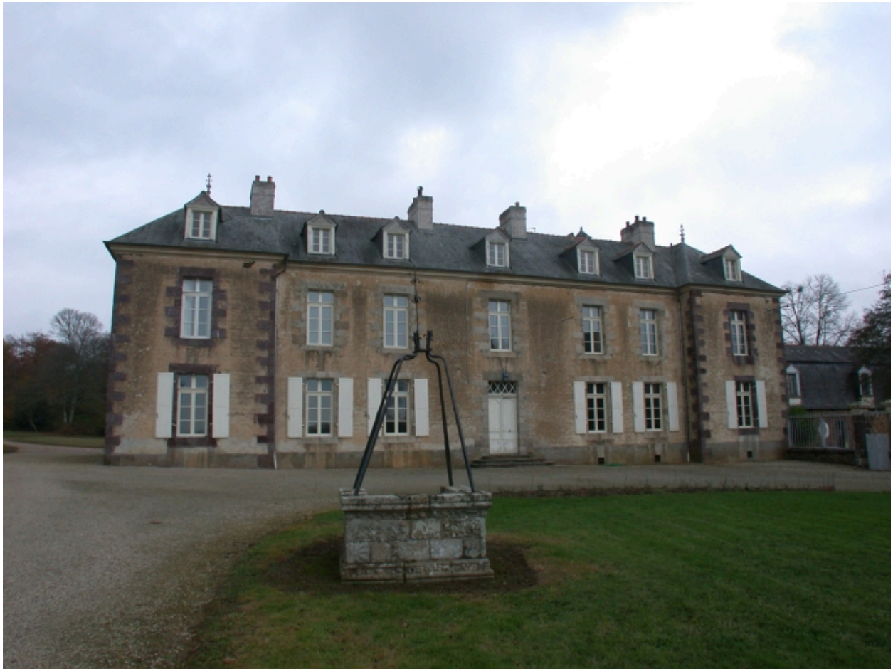
Vue générale du château, façade antérieure
