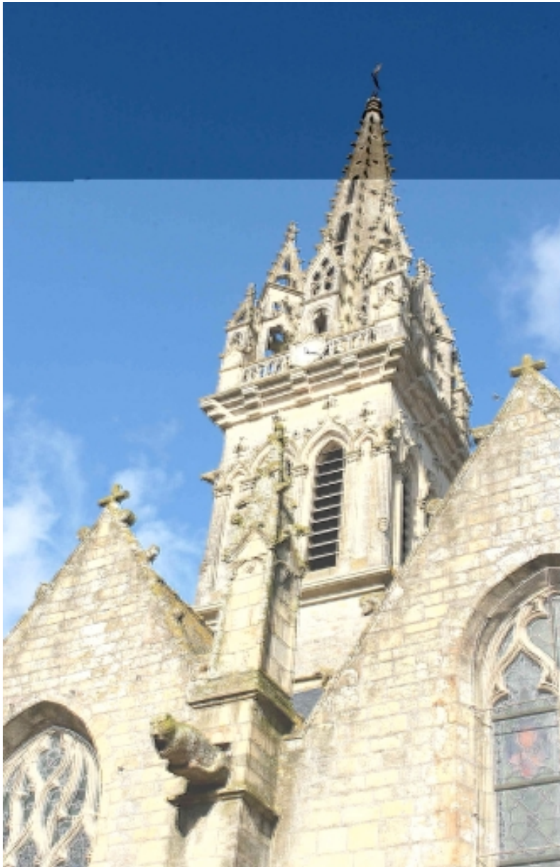
Le clocher, vue partielle sud-est
