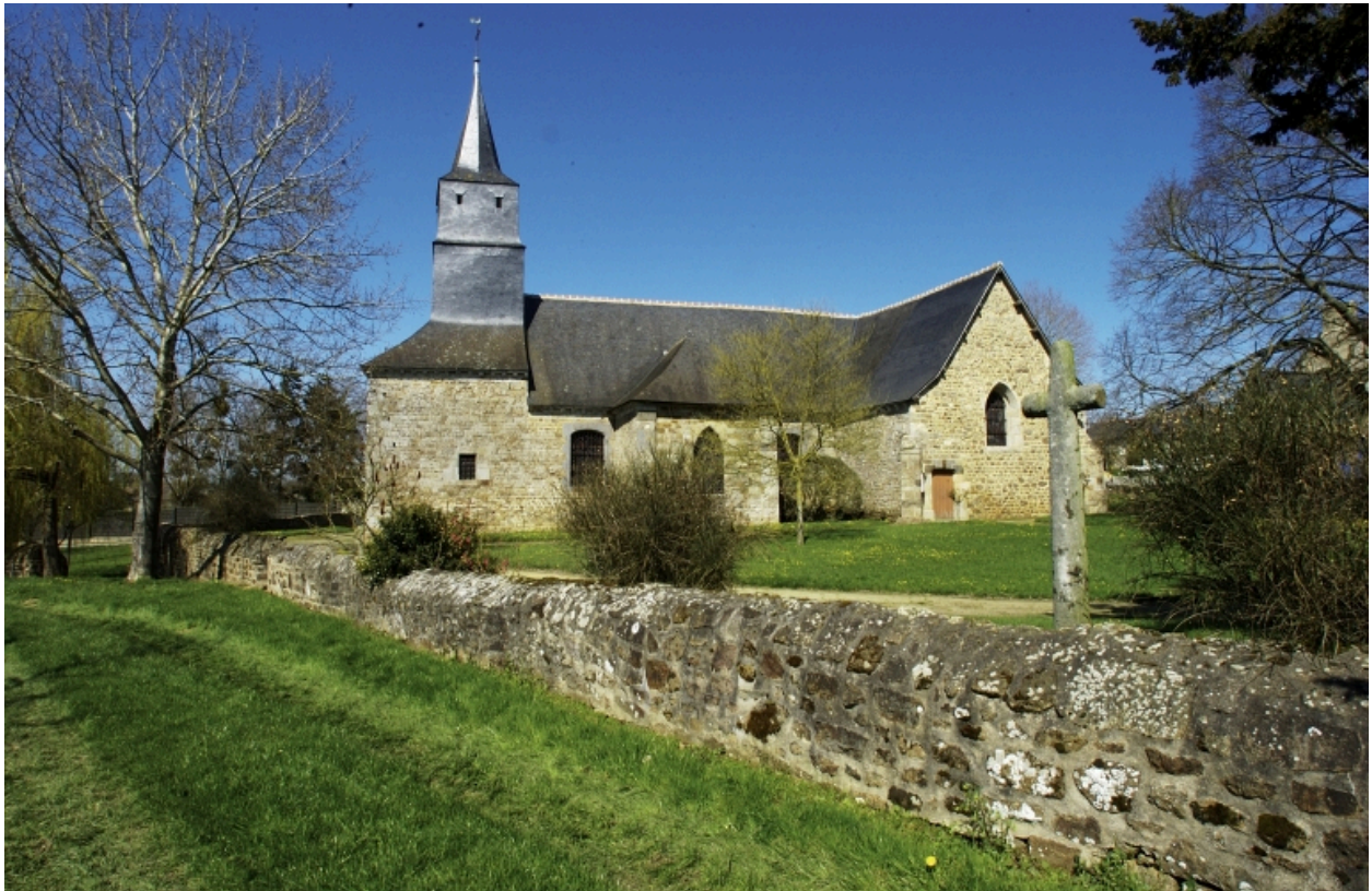
Vue générale Sud avec l'enclos et la croix
