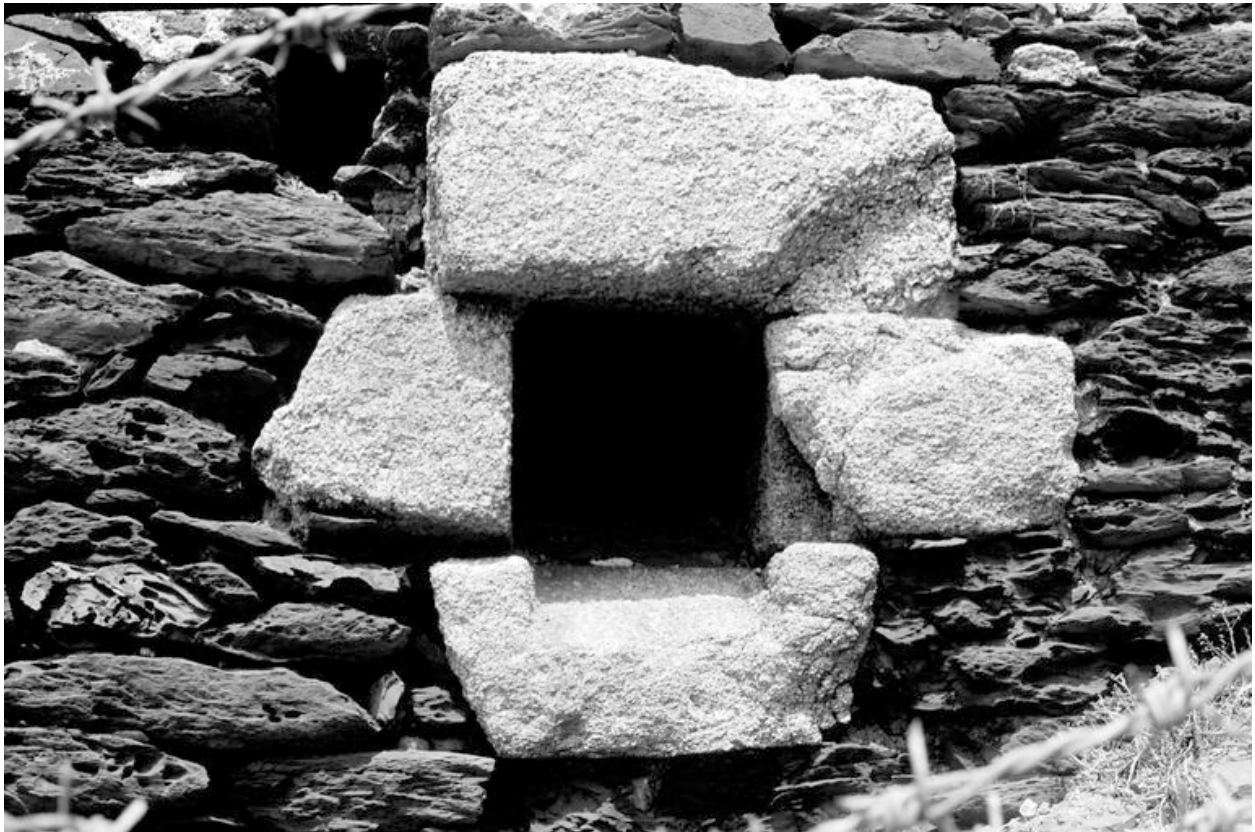
Vue de la batterie de Cornouaille en 1967 : extrémité ouest, exutoire des latrines, chaînes harpées en pierres de taille de granite
