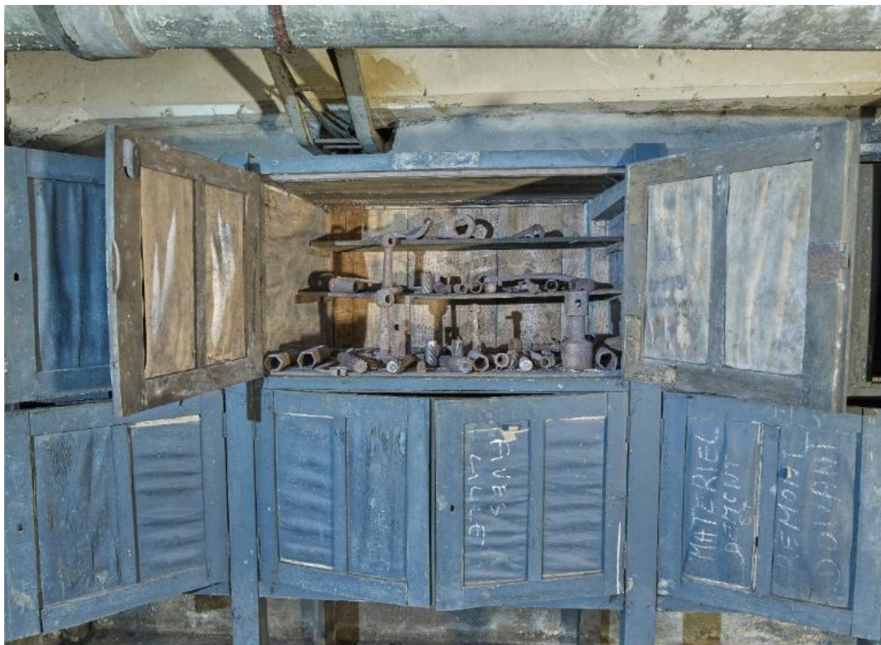
Vue du sous-sol de la salle des groupes électrogènes diesel : extrémité ouest, ensemble d'armoires d'atelier avec leurs outils et accessoires pour machine-outil
