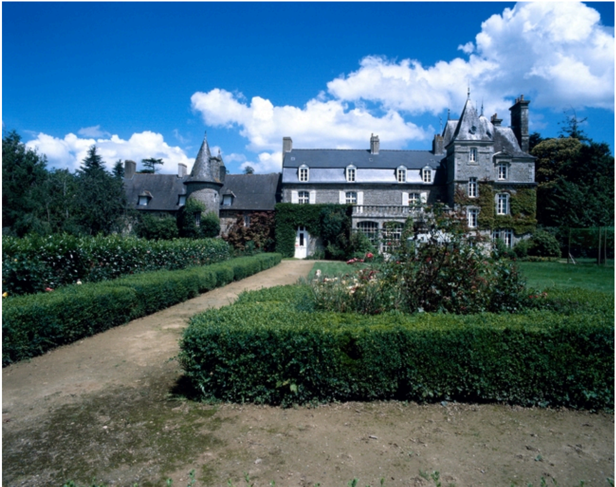
Façade postérieure : vue rapprochée.
