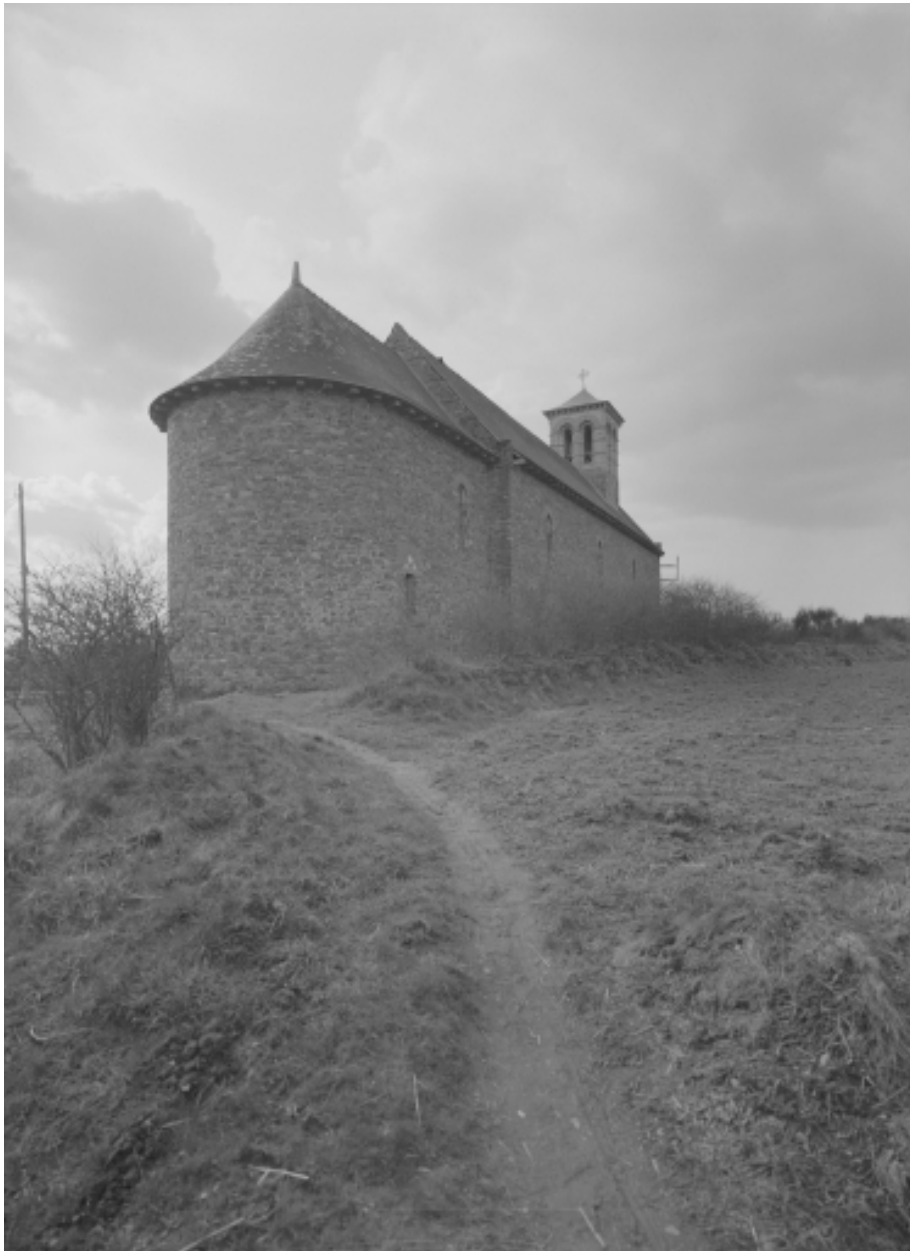
Elévation Nord-Est : vue générale
