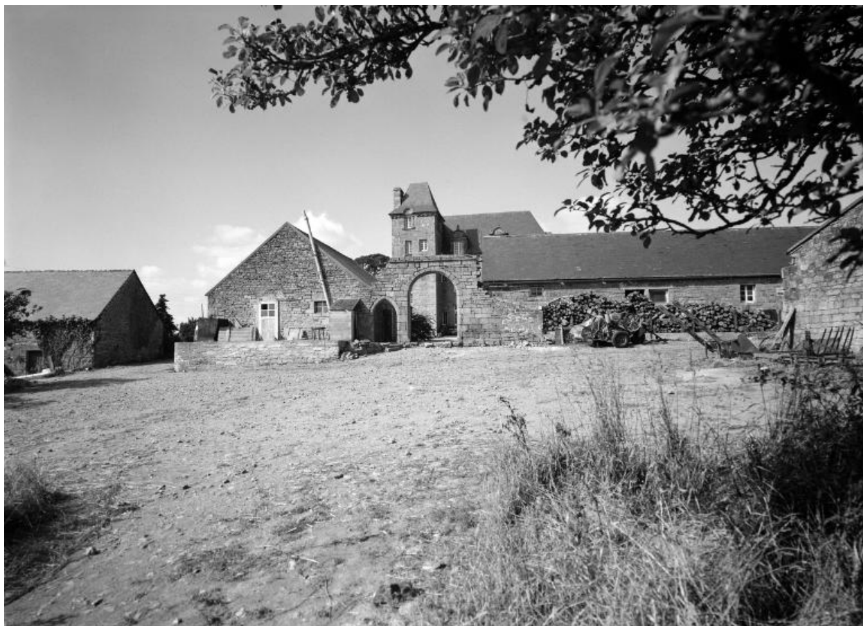
Vue de situation prise du sud
