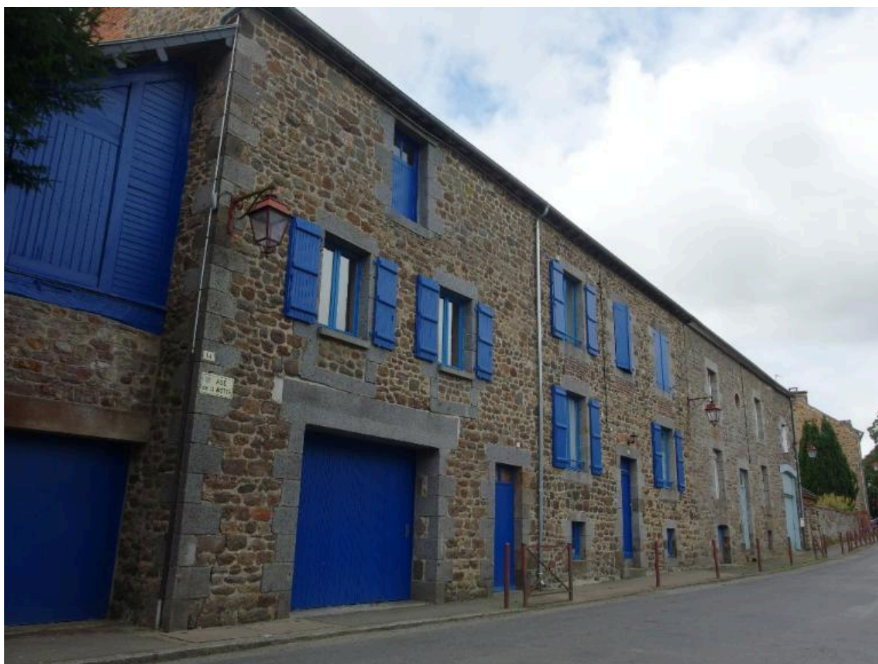
Vue de la façade nord
