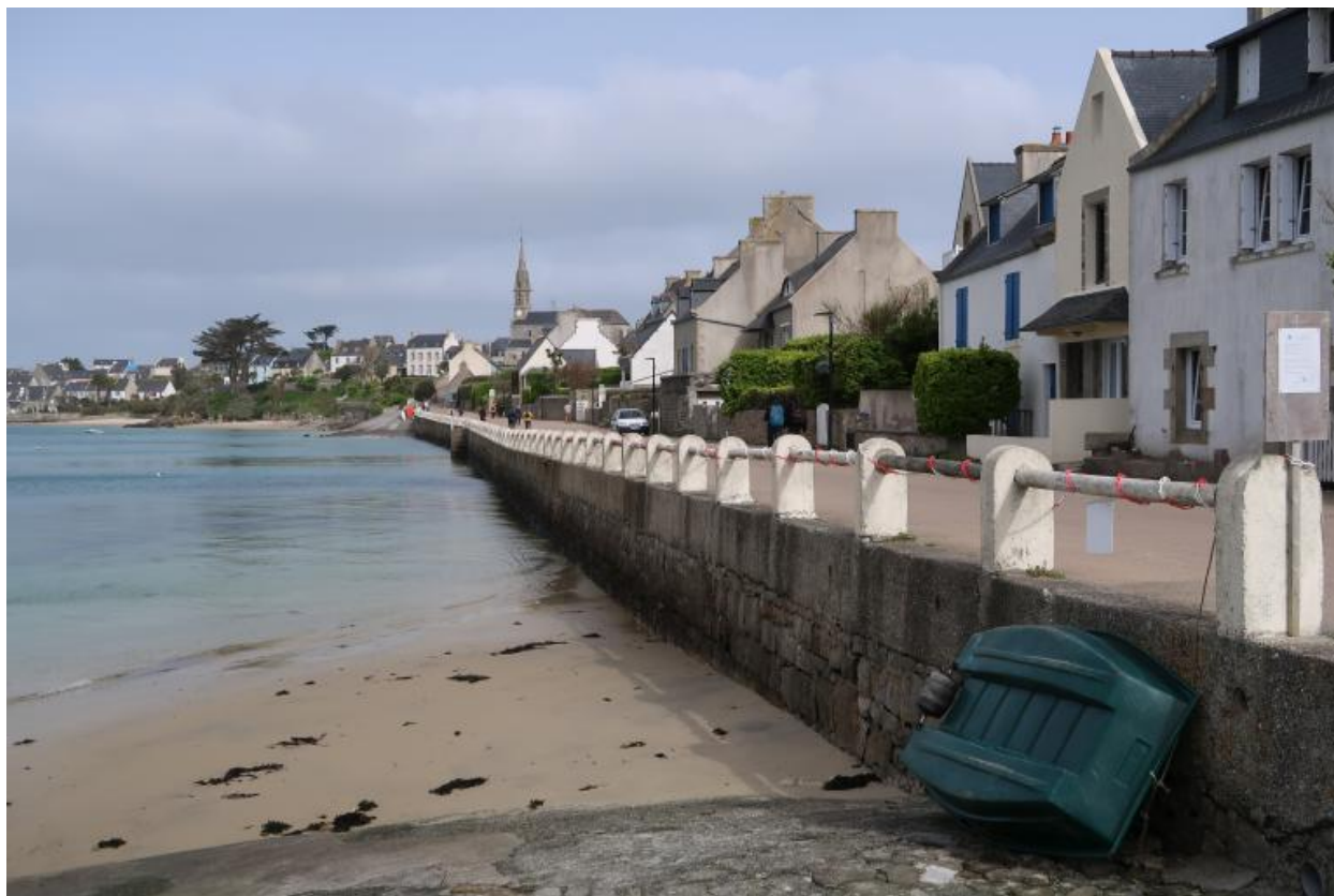
Porz Kernog, murs de soutènement de la route, partie est de la plage
