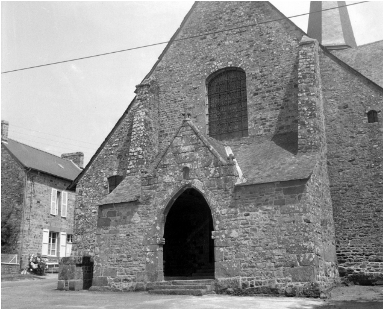
Etat en 1971, élévation ouest
