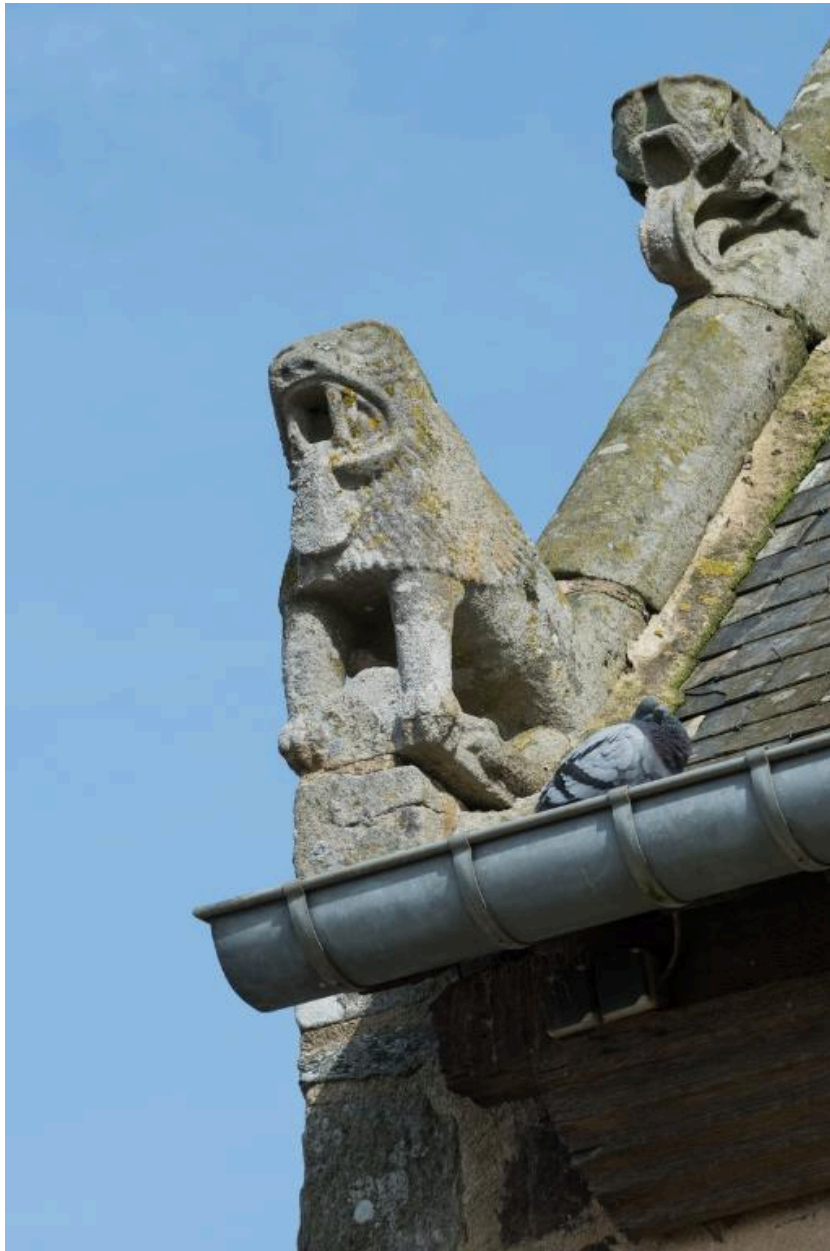
Détail des sculptures sur le rampant du pignon occidental
