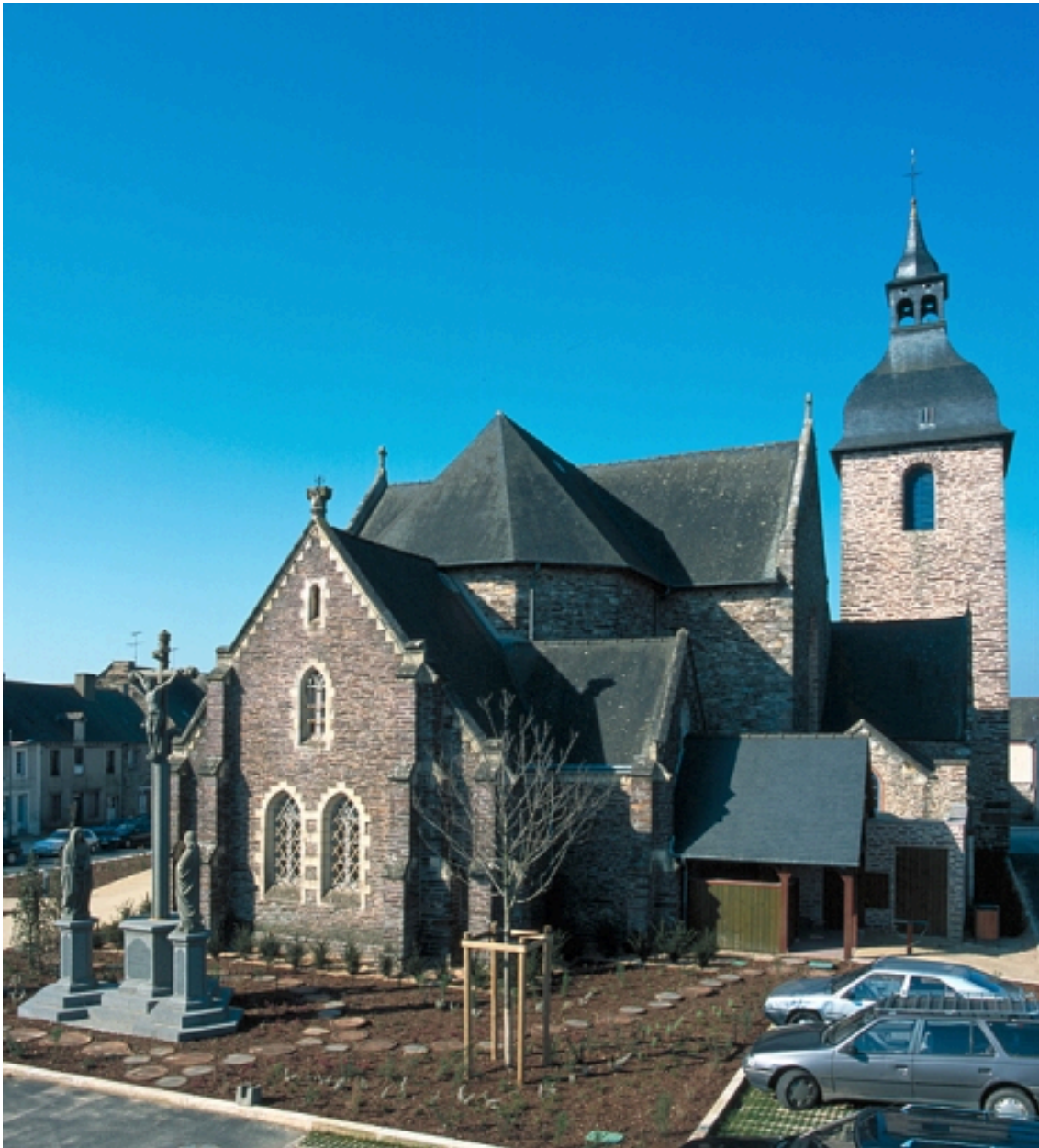
Vue générale est
