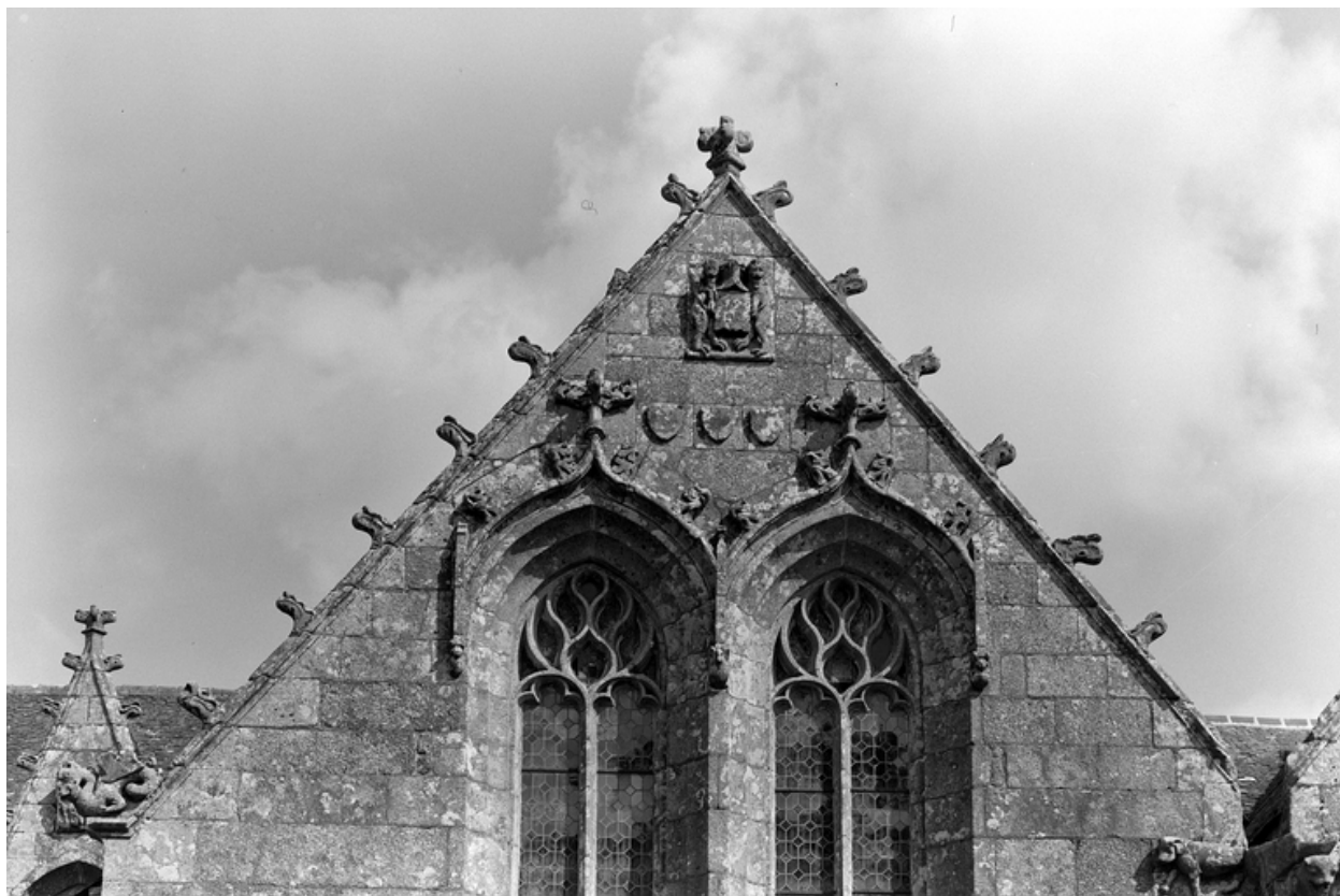
Croisillon occidental sud : détail de la partie supérieure de la façade sud
