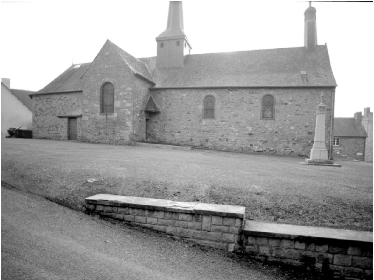
Elévation Nord : vue générale
