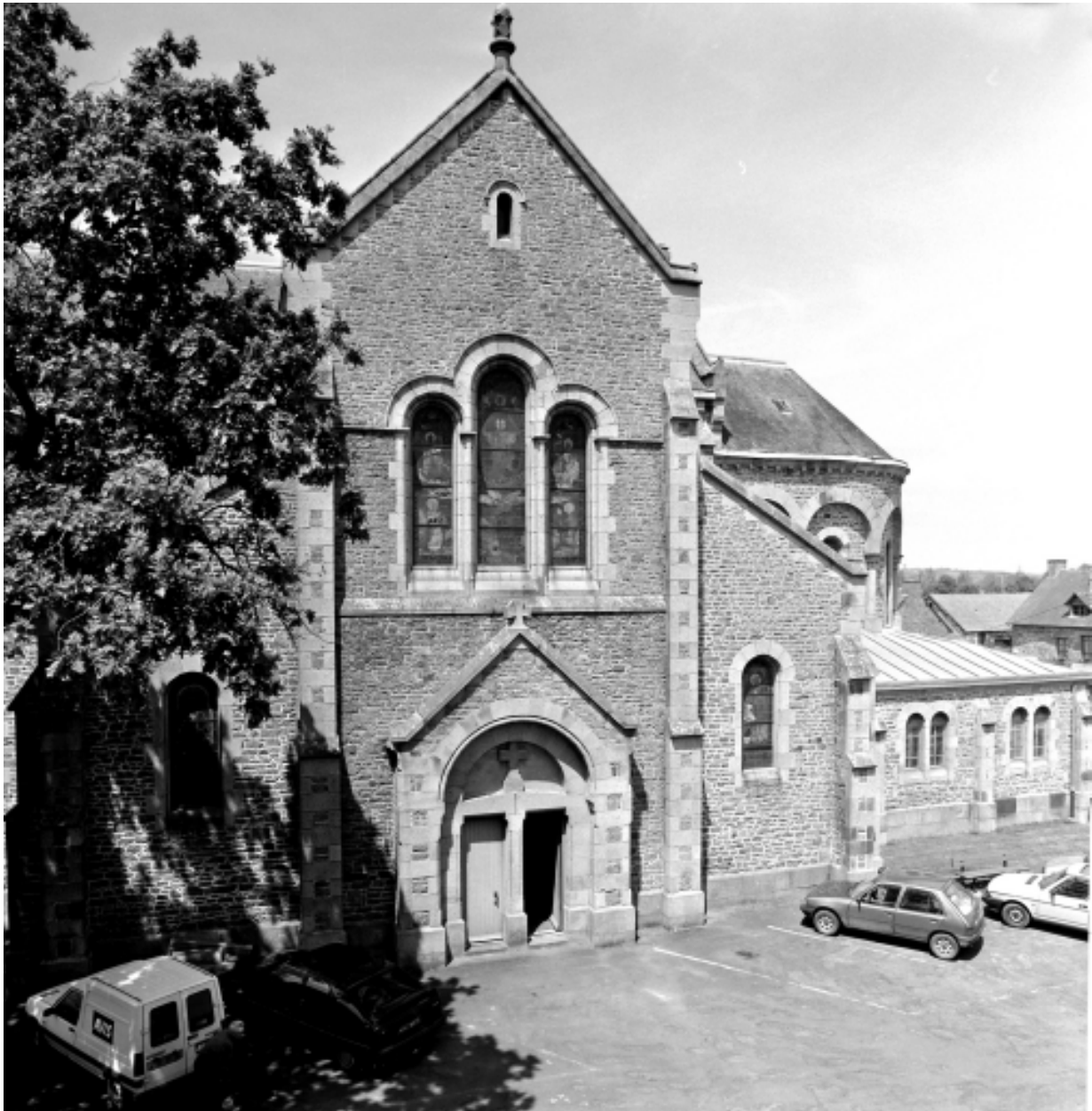
Elévation Sud, porte : vue générale
