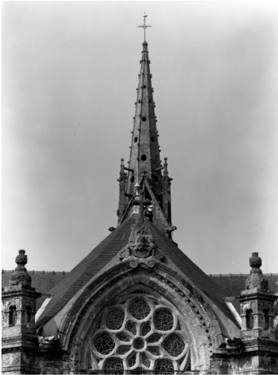
Plomodiern, église paroissiale Saint-Mahouarn : façade est, détail amortissement, état en 1972
