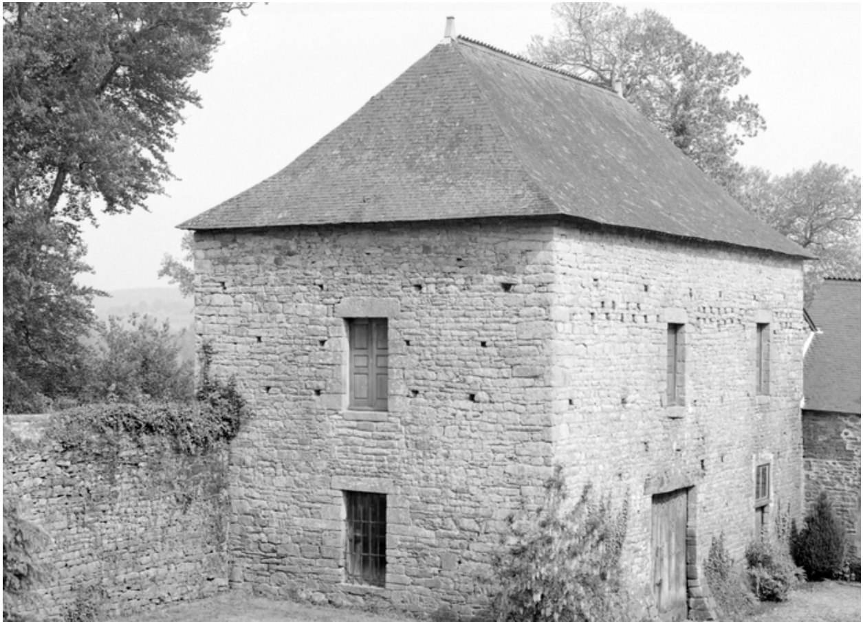
Remise avec pigeonnier : vue générale (état en 1984)
