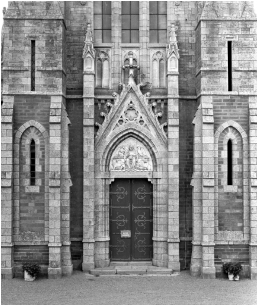
Élévation est, portail : vue générale
