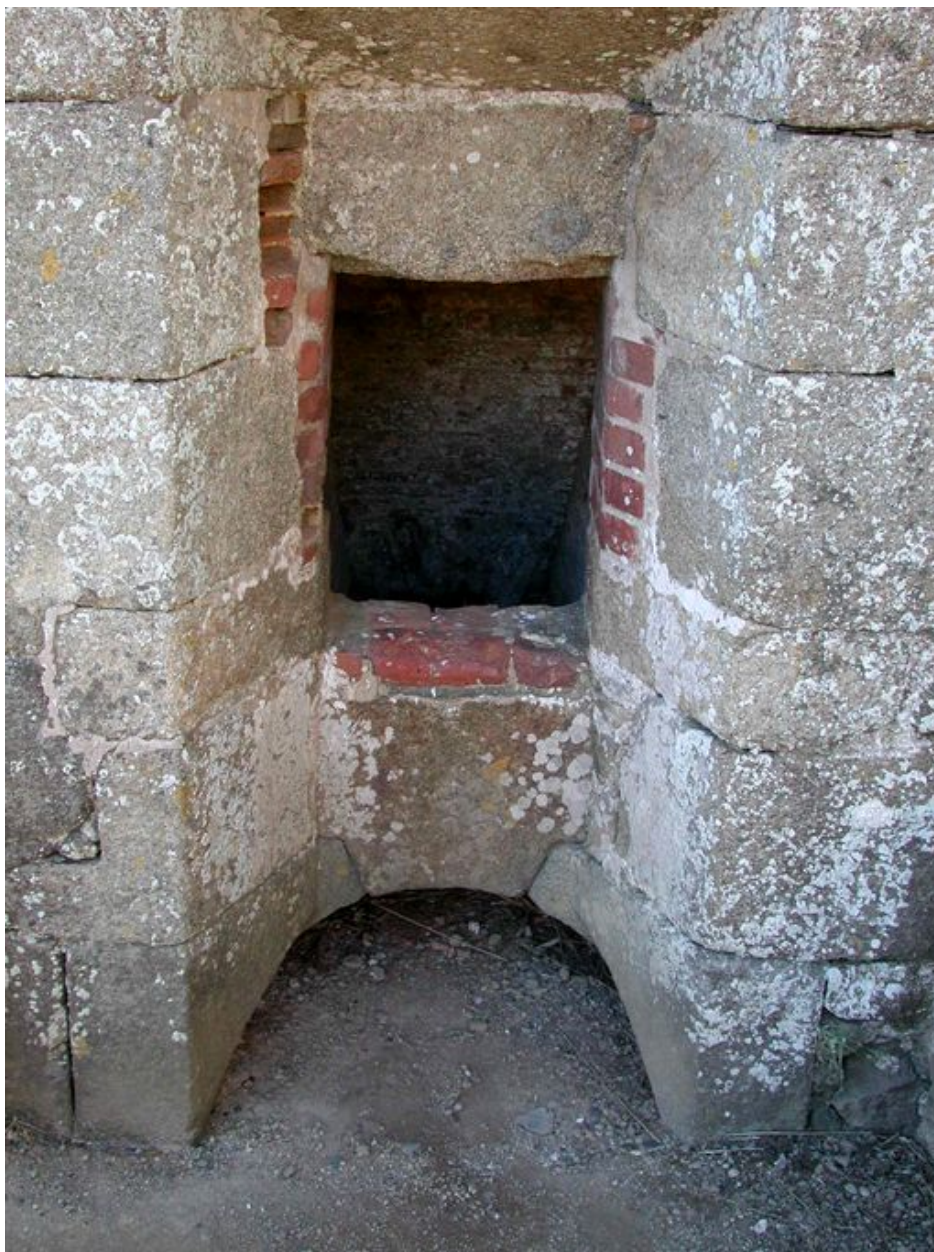
Vue de l'ouverture du foyer (état en 2002). Au ras du sol, jour de ventilation
