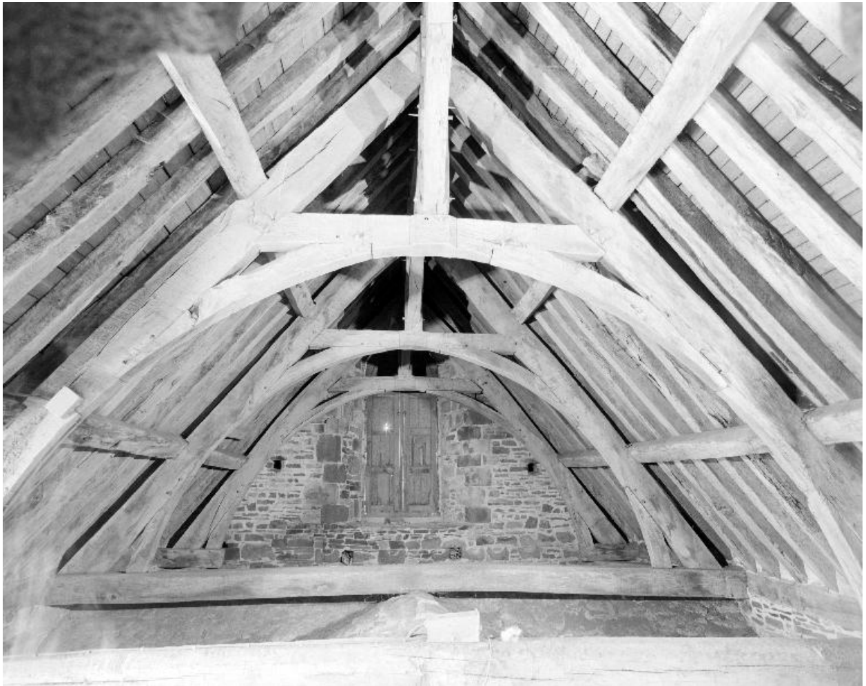
Transept sud, détail de la charpente
