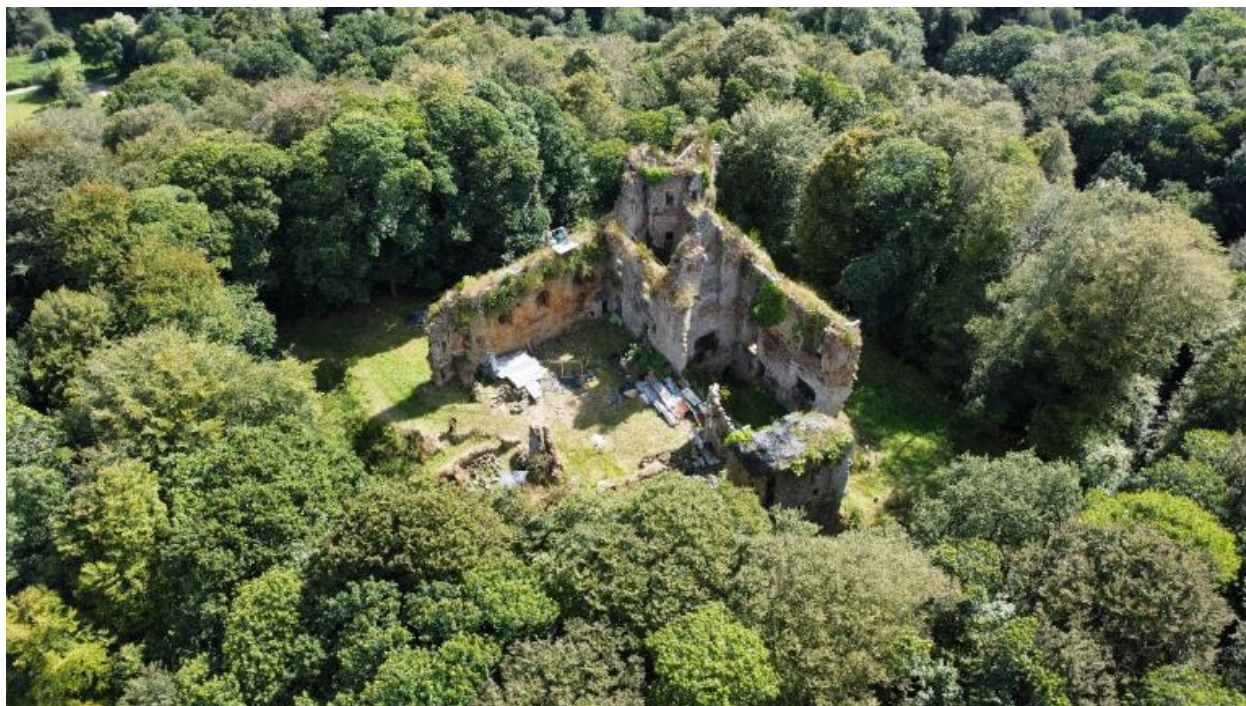
Vue aérienne oblique depuis le nord-ouest
