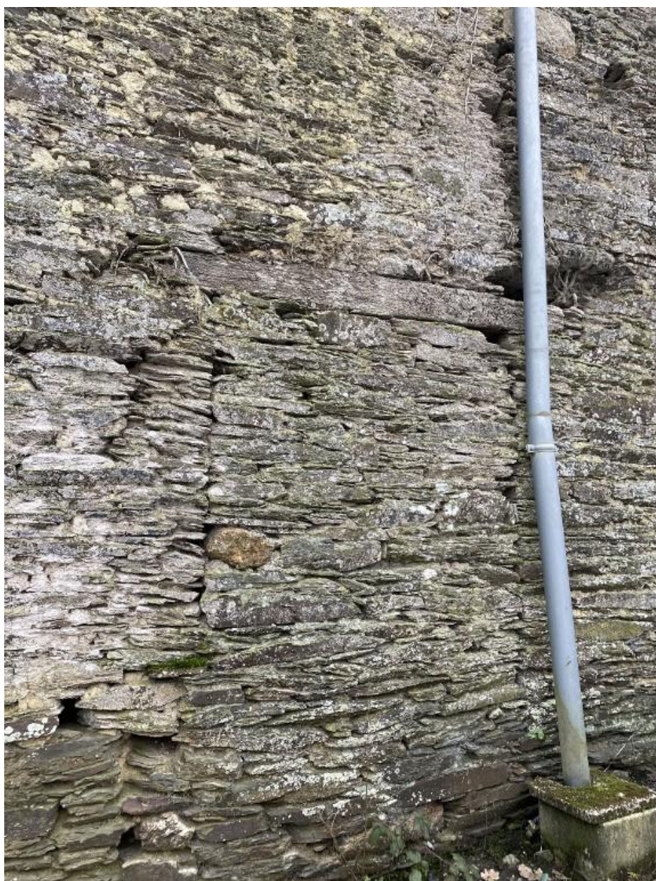
Aile nord, élévation nord, détail
