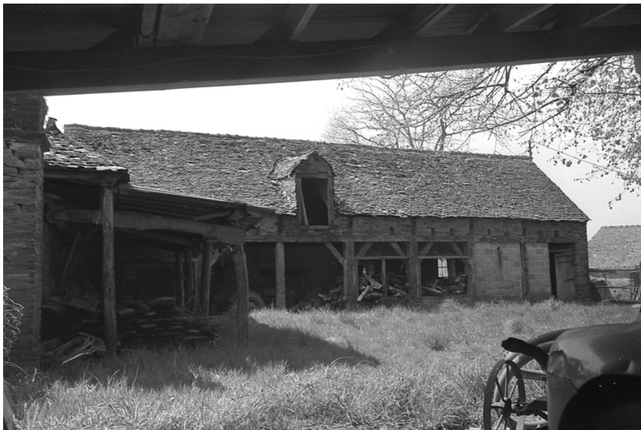
Dépendances : vue du sud-est
