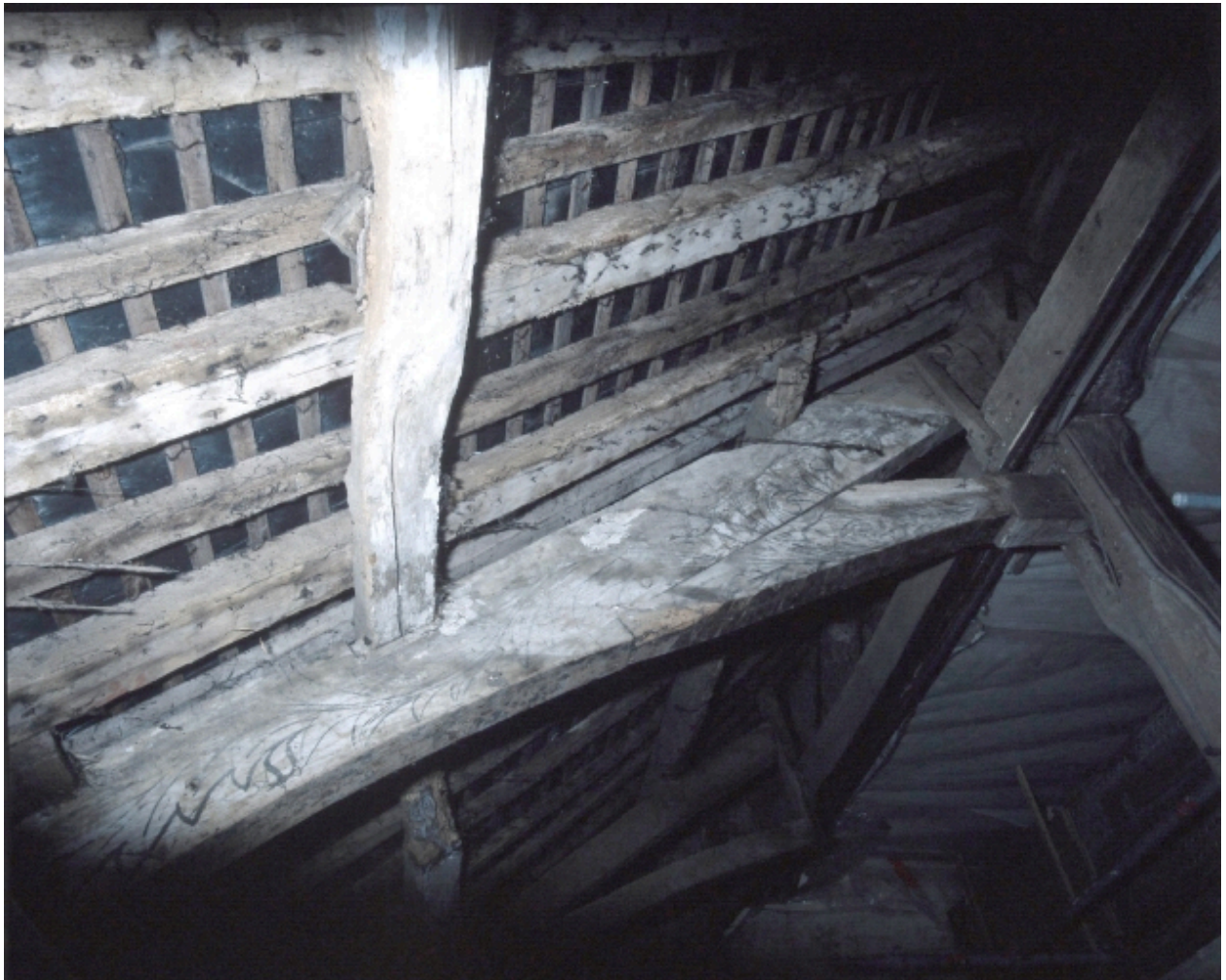
Détail sous charpente.
