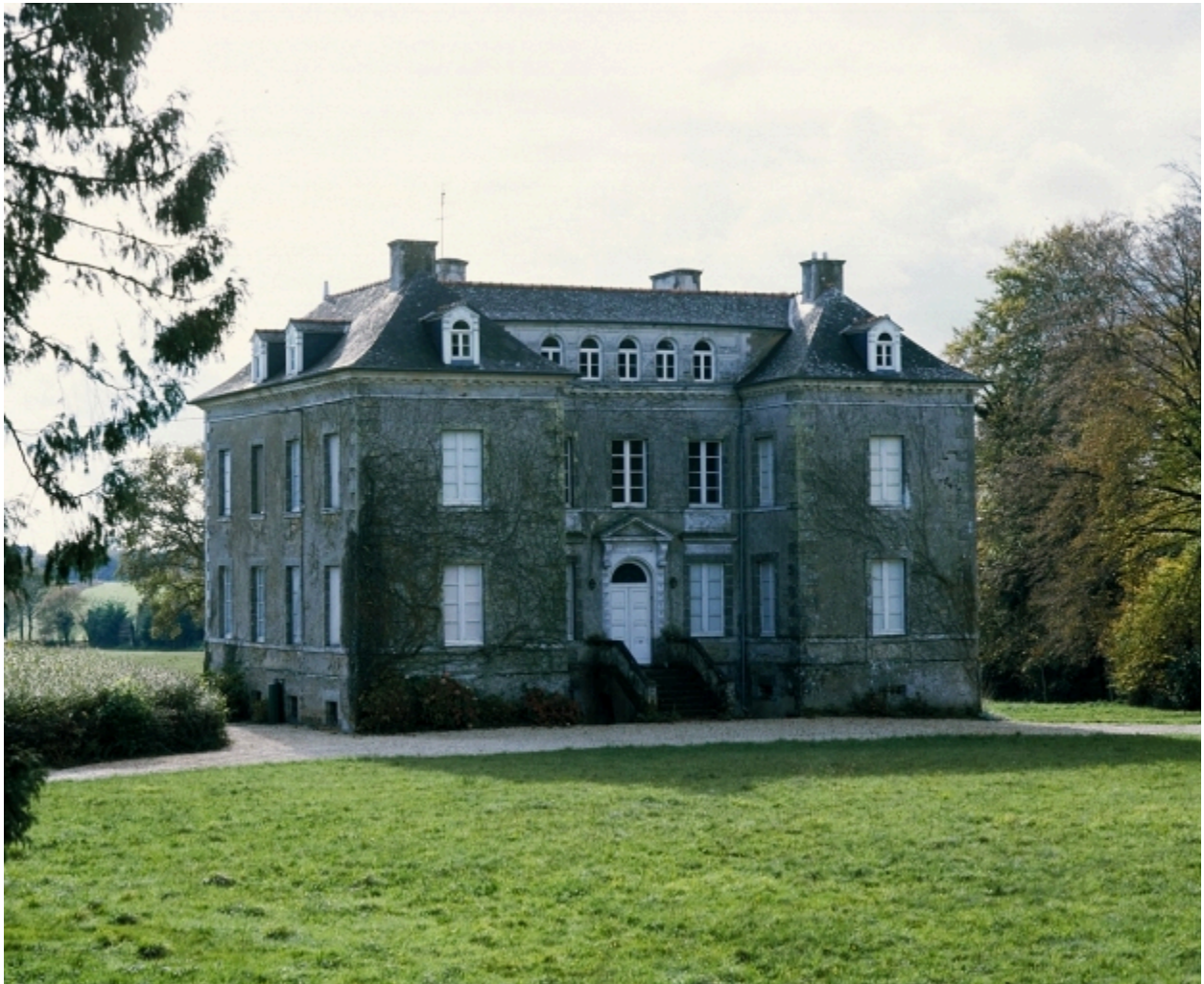
Façade antérieure : vue générale
