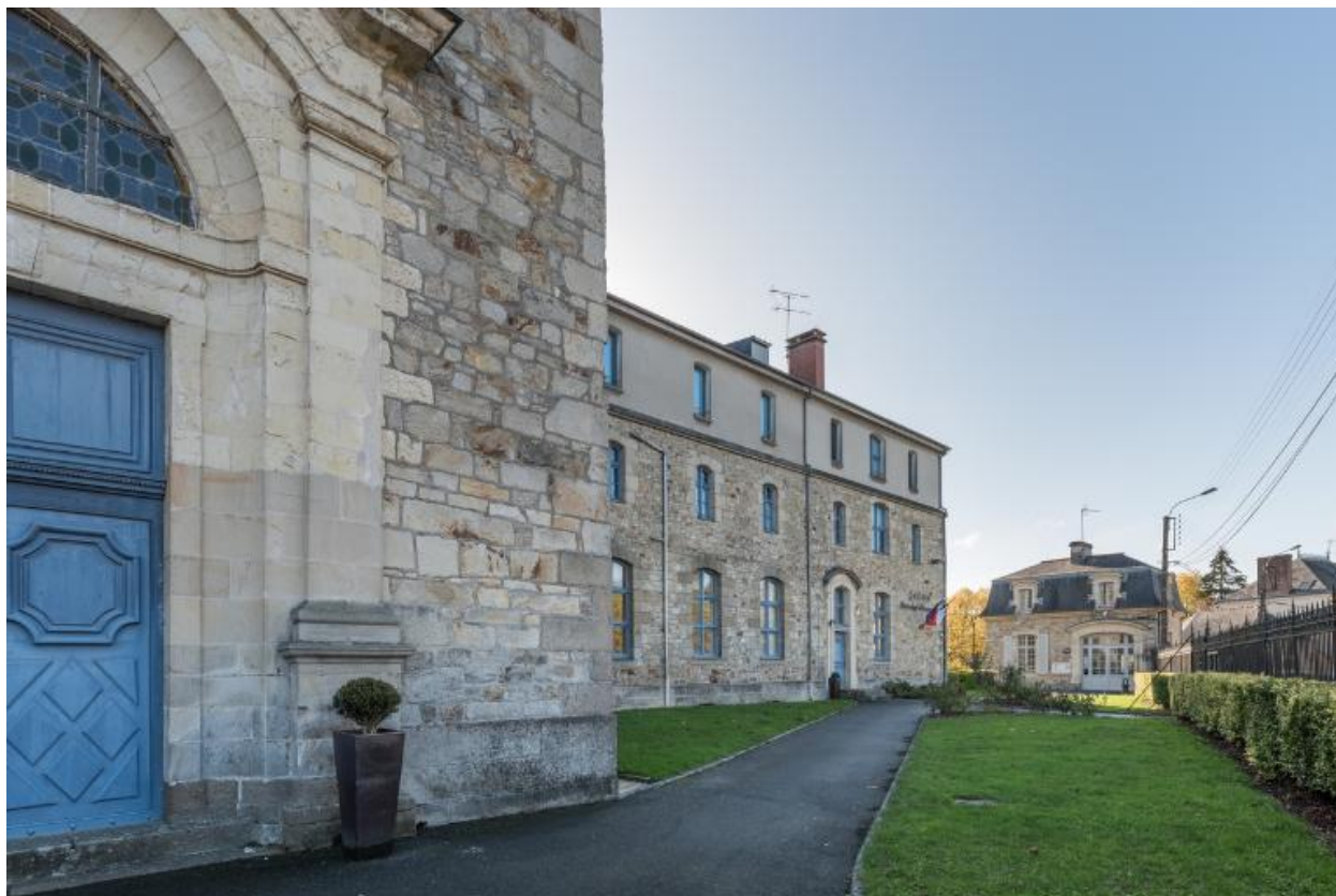
Bâtiment A (administration), façade nord. Au premier plan, l'entrée de la chapelle.
