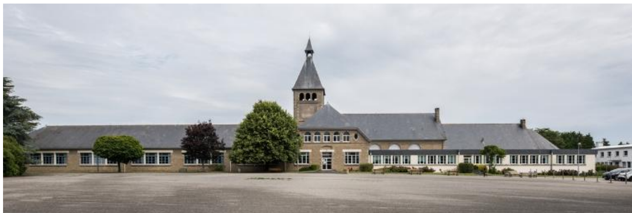
Vue d'ensemble prise du sud. Georges-Robert Lefort, architecte, 1929.
