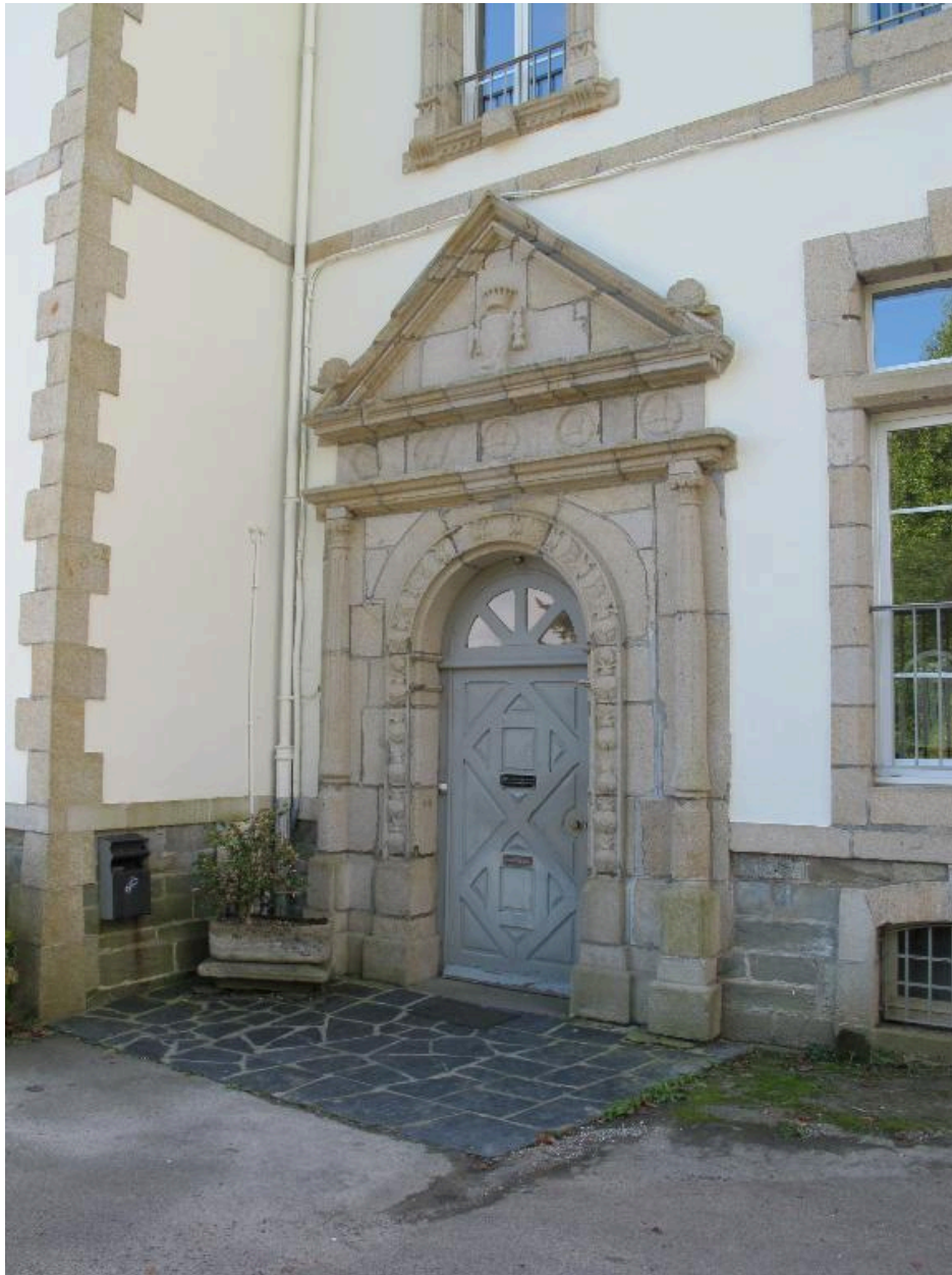
Toul ar c'hoat, façade nord, détail entrée
