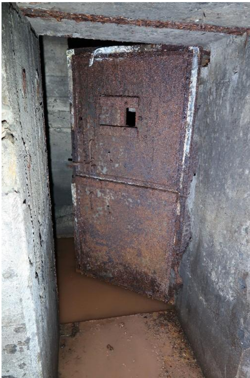
Vue de l'accès à la petite salle située au nord-est : une porte blindée à deux vantaux l'isole des salles de garde
