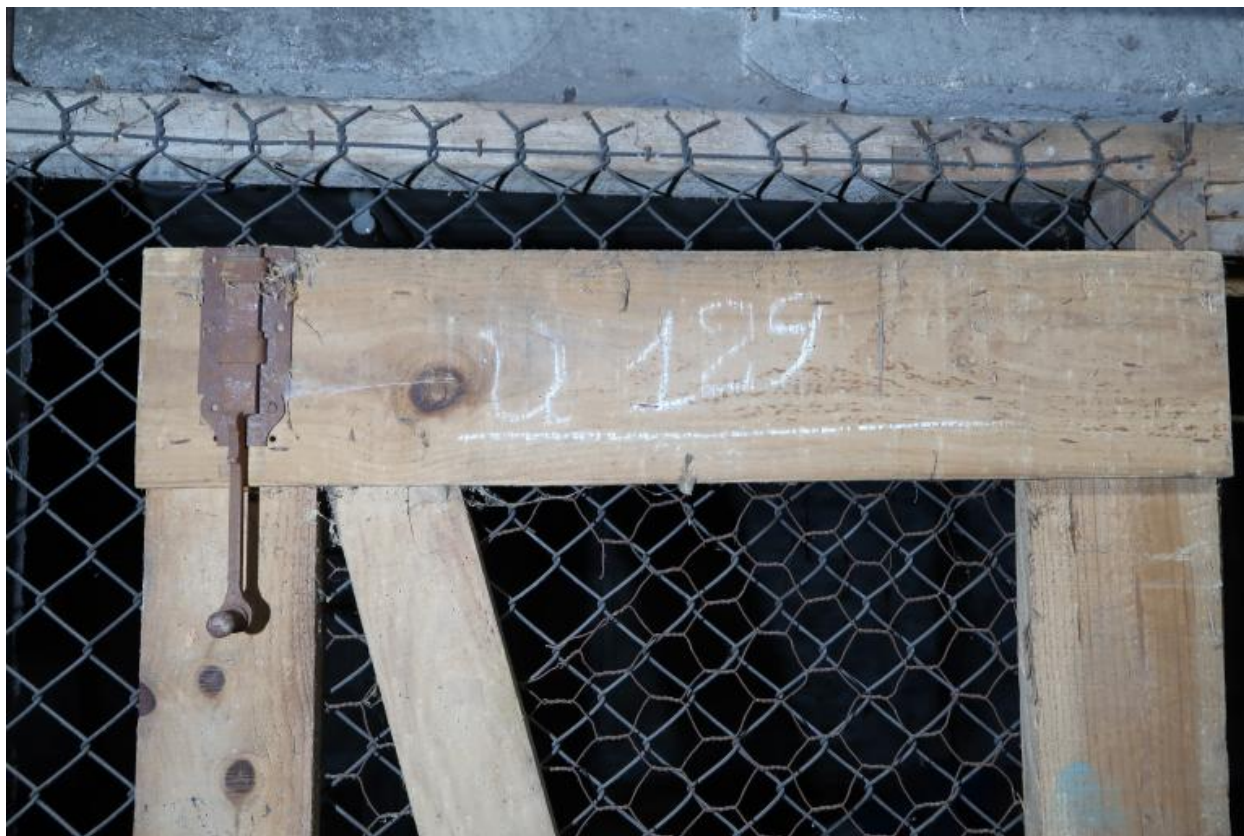
Rez-de-chaussée : marquage "U 129" [porte] (box 11)
