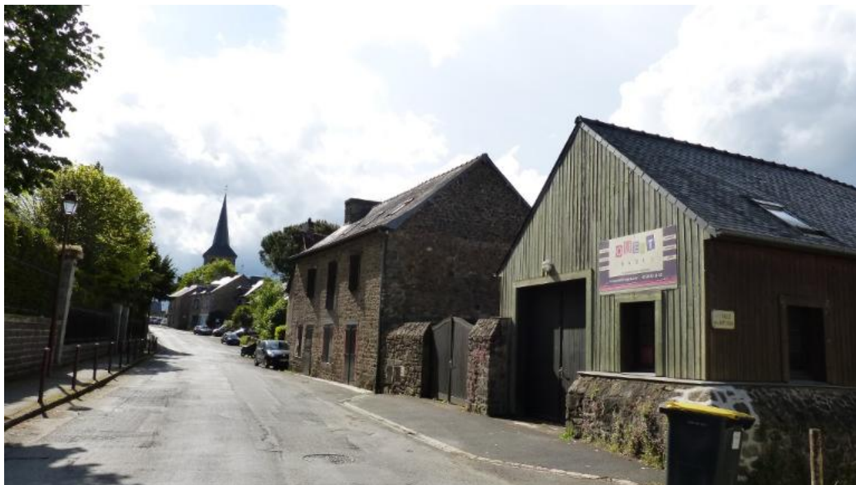
Vue de la façade sud
