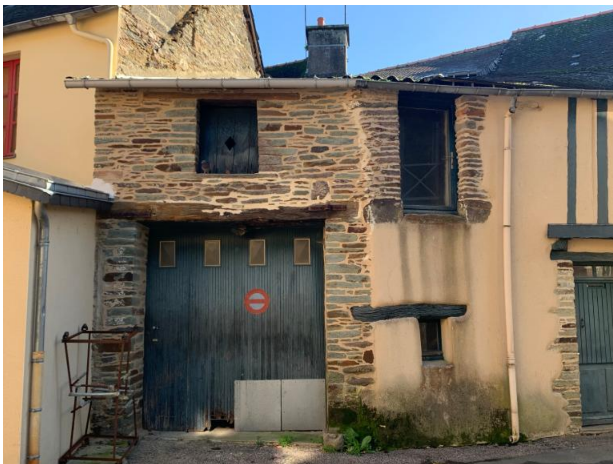
Elévation ouest, partie nord
