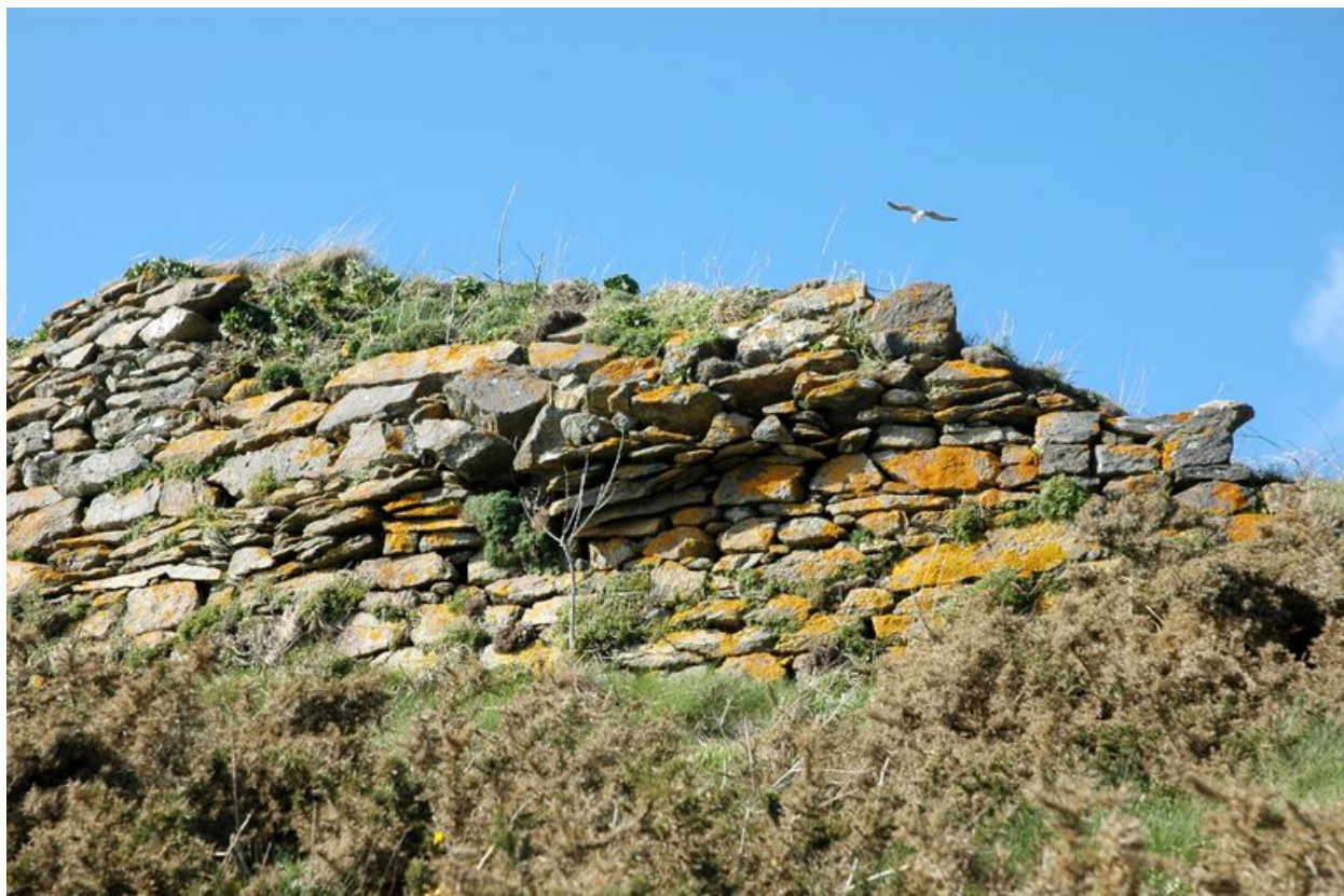
Vue de l'ensemble fortifié de Porsfeunteun : batterie de côte
