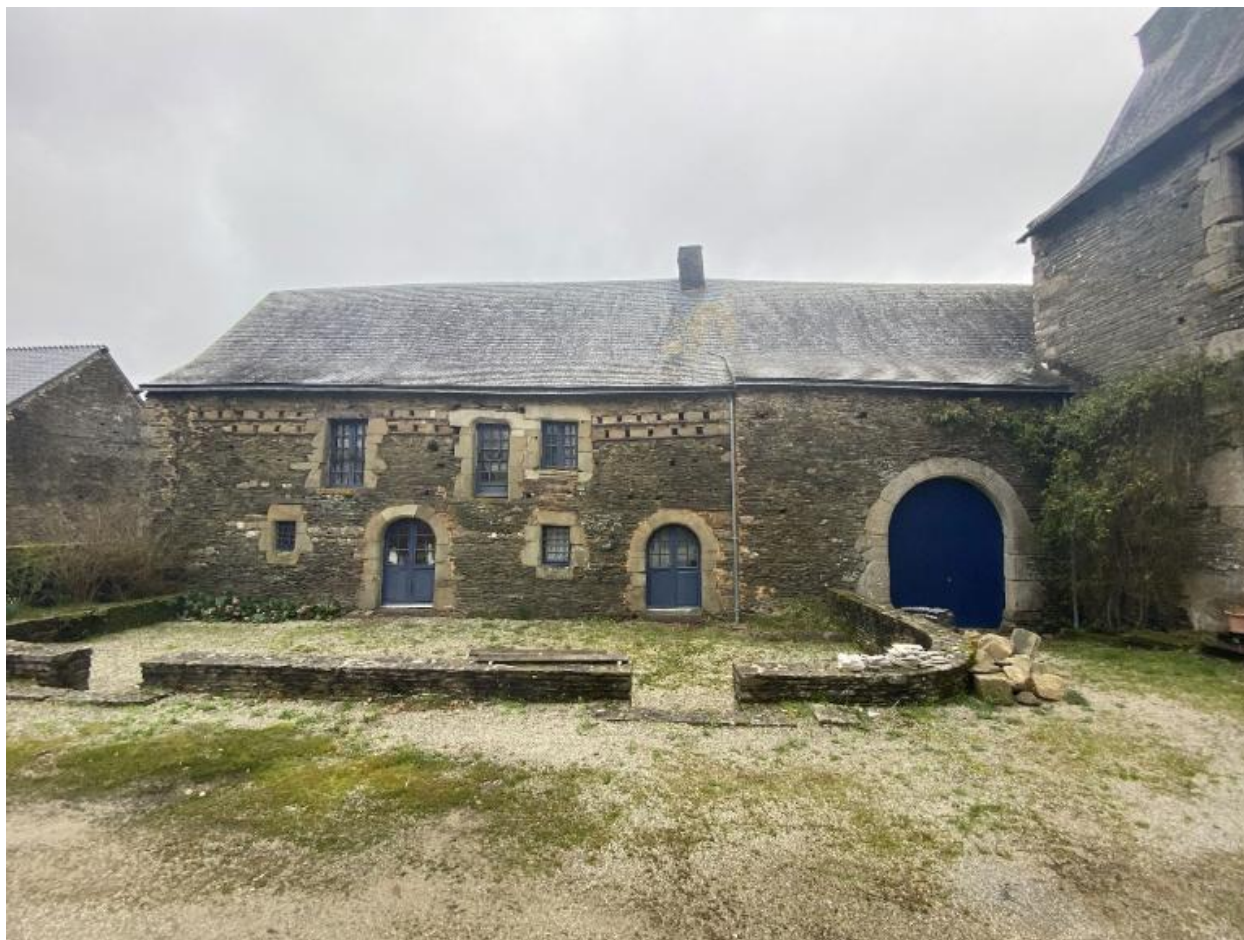
Aile nord, élévation sud, vue générale
