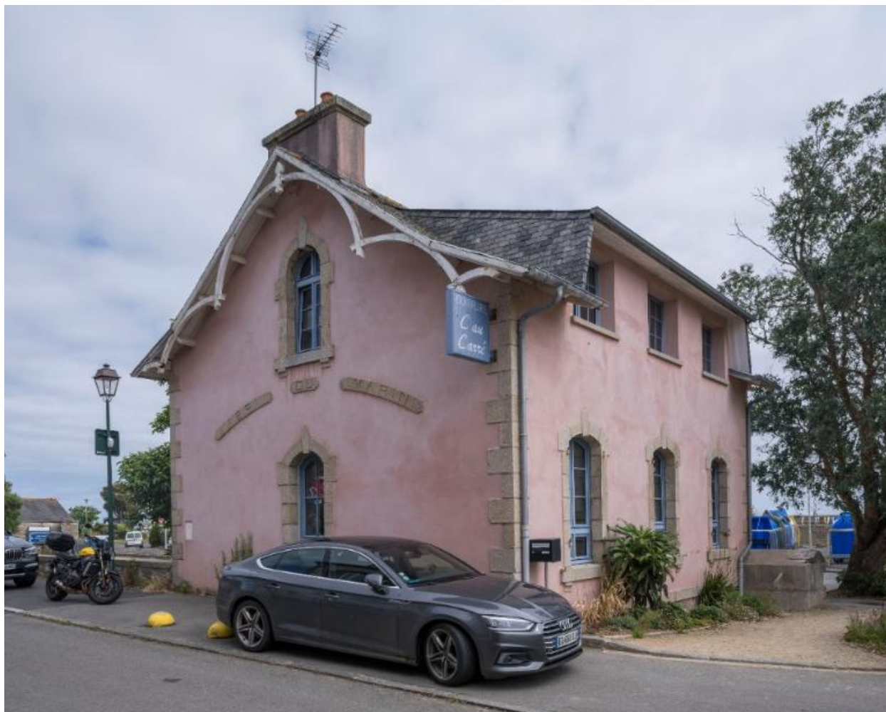
Abri du marin : élévation Est et pignon Sud avec inscription ABRI DU MARIN
