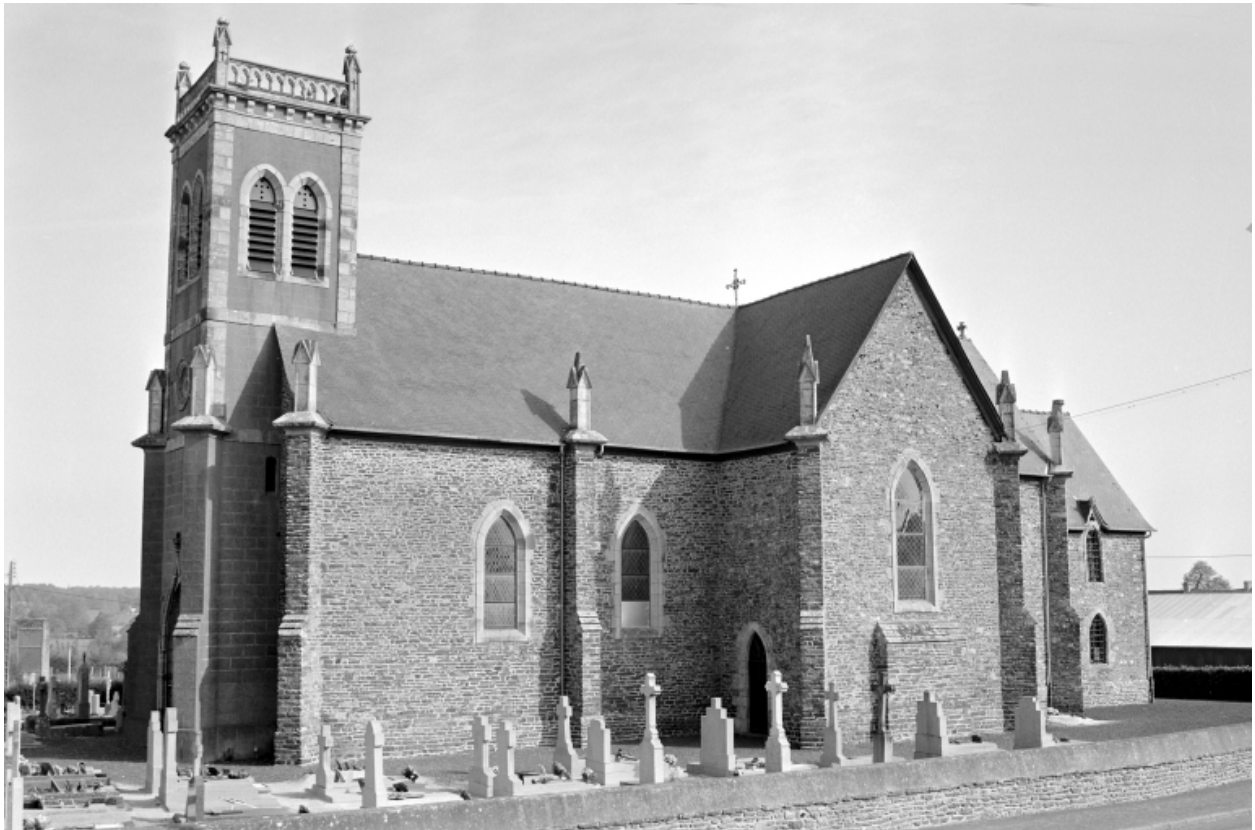
Elévation Sud-Ouest : vue générale
