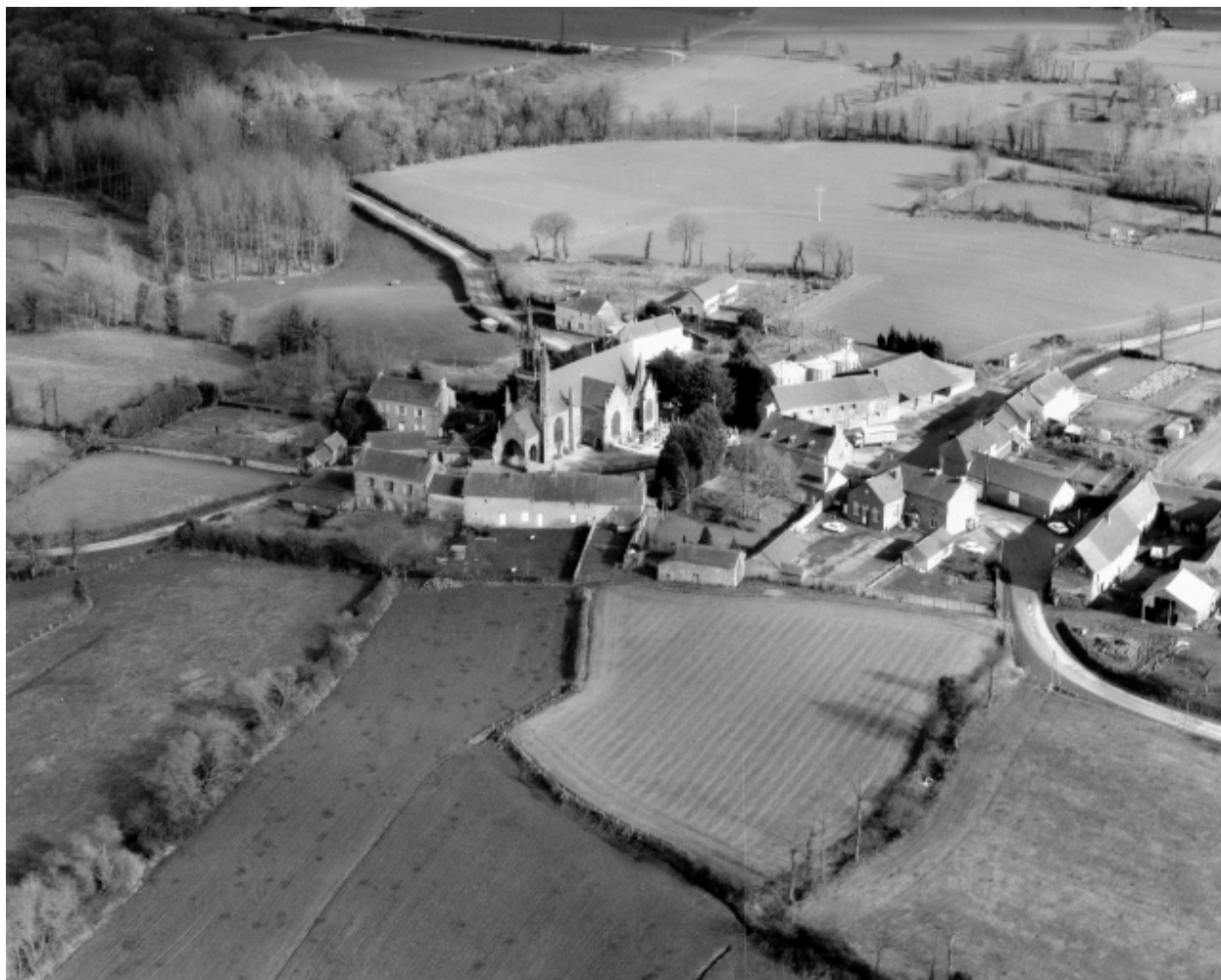
Vue aérienne prise du sud-ouest.
