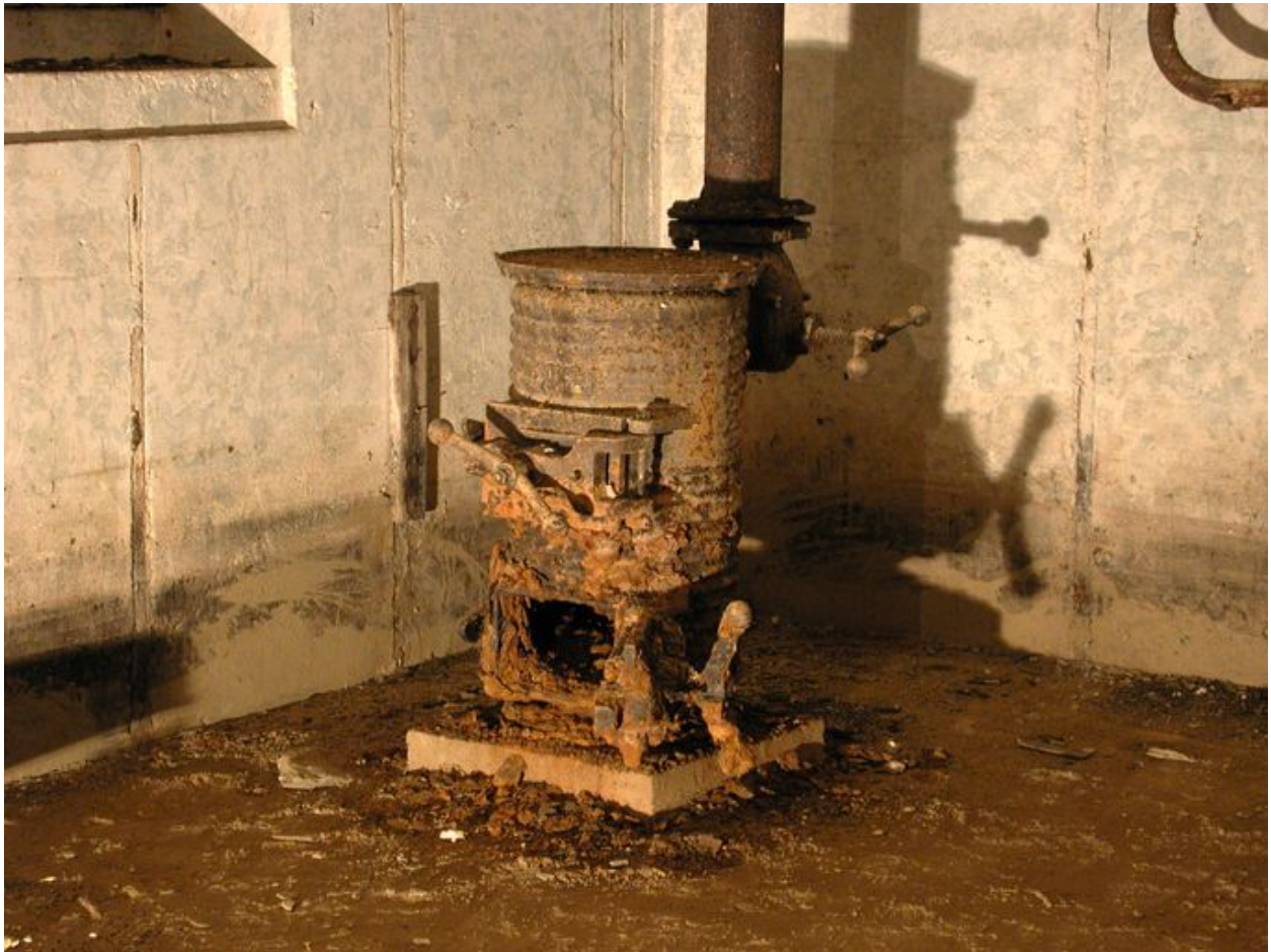
Vue du poêle de type Wt80K à plaque pour réchauffer les plats (chambre de troupe gauche)
