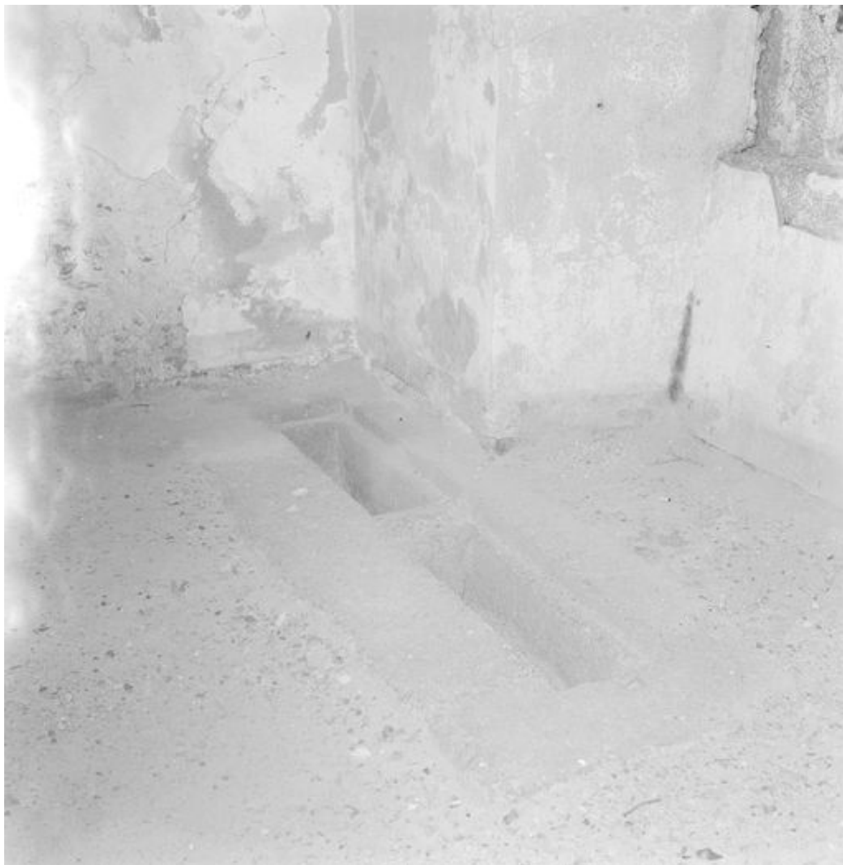
Vue des créneaux de pied ou assomoirs (état en 1969)
